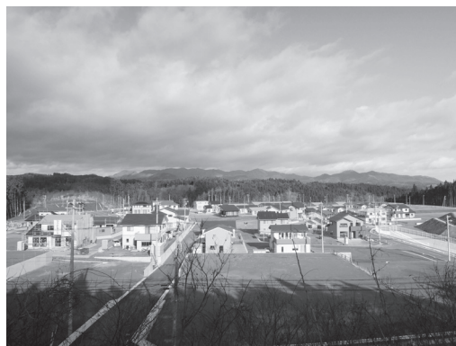
写真1 小泉地区の住宅再建の様子（2016年1月5日撮影）
