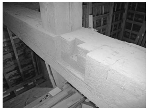
(図11) 陸梁にのこる風車台櫓土台受の痕跡
