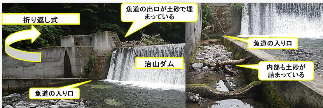
図 4-3-5 土砂で閉塞した折り返し式矩形魚道
