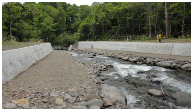
図 4-4-4 九助川治山ダムに併設された護岸工
