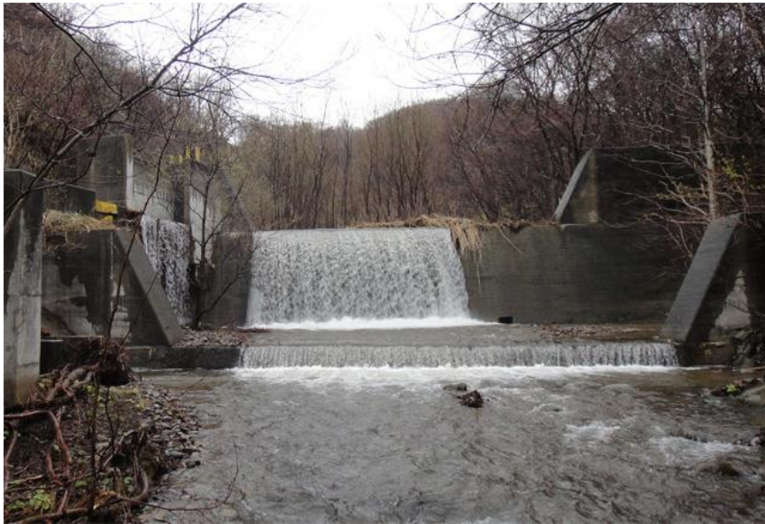
図 4-2-4. 堰堤工（旧瀬棚町良瑠石川スリット前）
