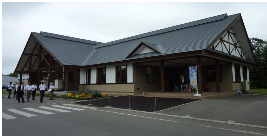
図 2.7 帯広市清掃センター外観
