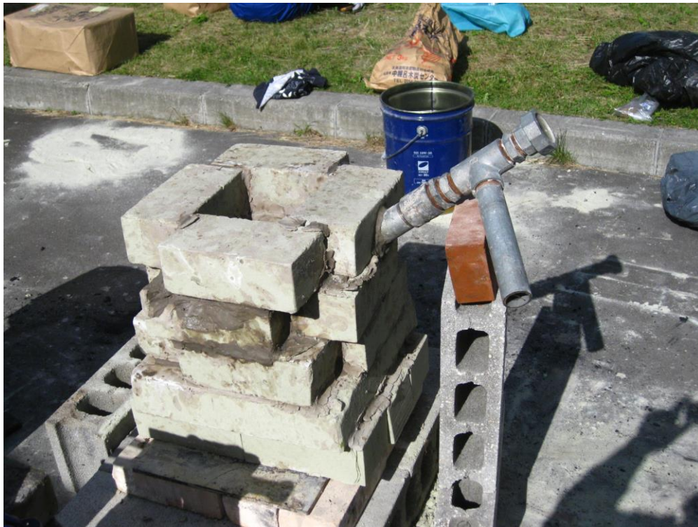
図2-42 レンガ型炉の下部の組み方
