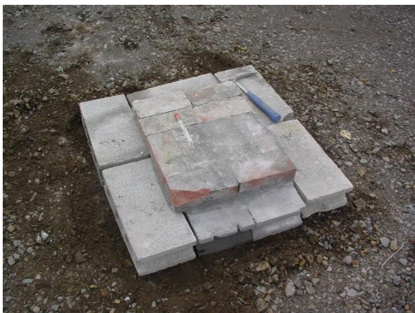
図 2-10 炉の土台下段と土台上段
