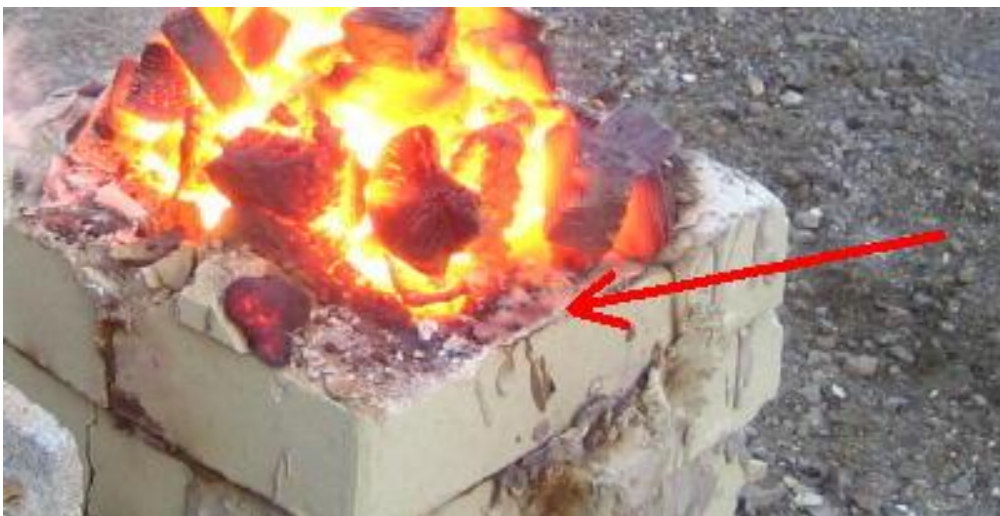
図 2-25 レンガ面で粘土が剥離し、隙間が生じていた
