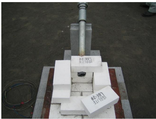
図 2-13 羽口用パイプの設置
