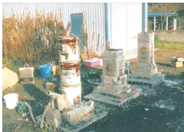
図2-2 1999年11月22日 実験炉（奥側:3号炉 中:4号炉）
