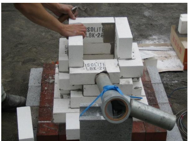
図 2-14 4 段目以降の積み上げ
