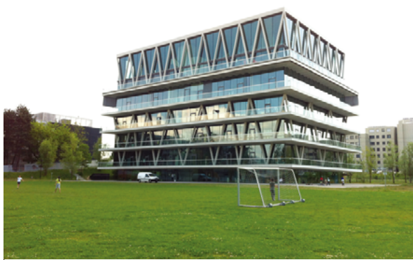
No. 193 (第 16 回) 作品名：Schulhaus Leutschenbach 施主：Stadt Zürich, Amt für Hochbauten 設計者：Christian Kerez 竣工年：2009
