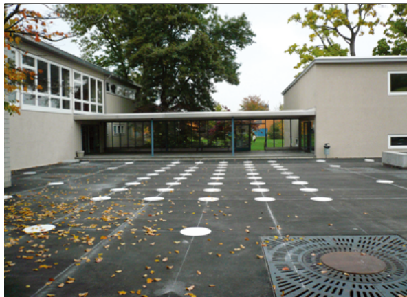
No. 44 (第4回) 作品名：Schulhausanlage <Luchswiesen> 施主：Stadt Zürich 設計者：Max P. Kollbrunner 竣工年：1957
