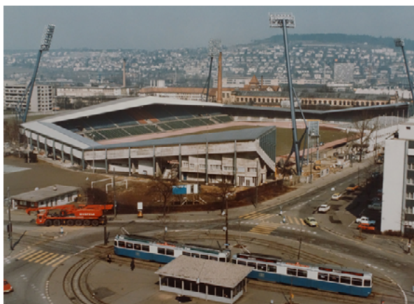
No. 59 (第5回) 作品名：Sportanlage Letzigrund 施主：Stadt Zürich 設計者：William Dunkel 竣工年：1958
