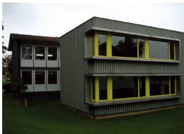
No. 166 (第14回) 作品名: Schulhaus Ahorn 施主: Stadt Zürich 設計者: Patrick Gmür Architekten 竣工年: 2002
