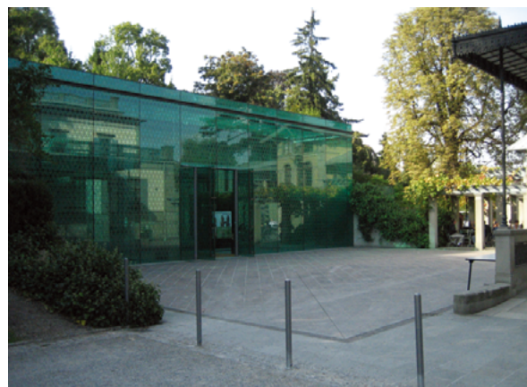
No. 192 (第 16 回) 作品名：Museum Rietberg 施主：Stadt Zürich, Amt für Hochbauten 設計者：ARGE Grazioli Krischanitz GmbH 竣工年：2006
