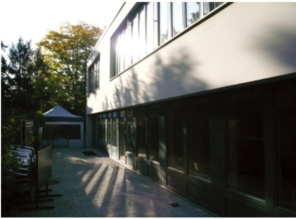
No. 53 (第 5 回) 作品名：Kirchgemeindehaus Hottingen 施主：Kirchgemeinde Hottingen 設計者：Karl Flatz 竣工年：1959
