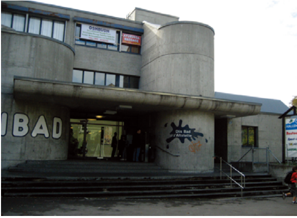
No. 101 (第9回) 作品名：Hallenbad Altstetten 施主：Stadt Zürich 設計者：Bolliger, Honger, Dubach 竣工年：1973
