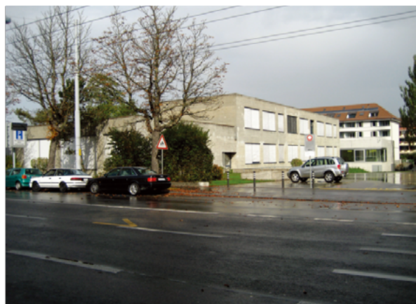
No. 70 (第6回) 作品名：Werkschulhaus Hardau 施主：Stadt Zürich 設計者：Otto Glaes & Rudolf Lienhard 竣工年：1965
