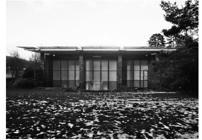
写真 5-4-3 パイエラー美術館
