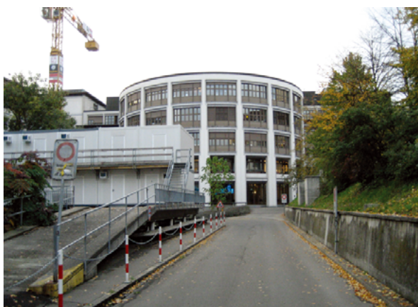
No. 145 (第12回) 作品名：Hörsaaltrakt Universitätsspital Zürich 施主：Hochbauamt des Kantons Zürich 設計者：Joachim Naef, Ernst Studer 竣工年：1990
