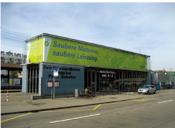
No. 165 (第14回) 作品名: Pneushop - Art Exchange 施主: Christian Schaller 設計者: Camenzind Grfensteiner, Susanne Zenker 竣工年: 2002
