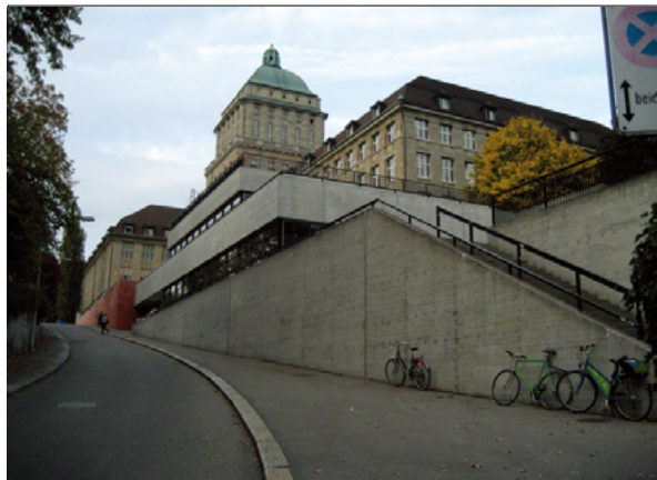
No. 92 (第8回) 作品名：Mensa der Universität Zürich 施主：Baudirektion des Kantons Zürich 設計者：Werner Frey, Franz M. Richner 竣工年：1969
