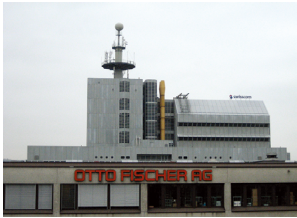
No. 116 (第10回) 作品名：Fernbetriebszentrum 3, Zürich-Herdern 施主：Generaldirektion PTT, vertreten durch die Hochbau- abteilung, Bern 設計者：Theo Hotz 竣工年：1978
