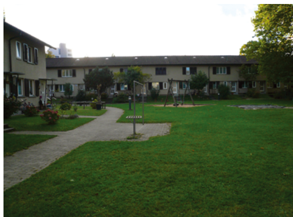
No. 16 (第3回) 作品名：Kolonien am Glattbogen 施主：Arbeiter-Siedlungsgenossenschaft Zürich 設計者：A.F. Sauter & A. Dirler 竣工年：1952
