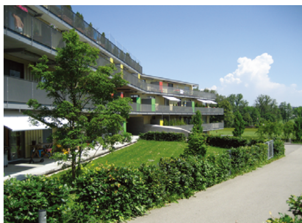
No. 184 (第16回) 作品名：ABZ Siedlung Wolfswinkel 施主：Allgemeine Baugenossenschaft Zürich 設計者：Egli Rohr Partner 竣工年：2007
