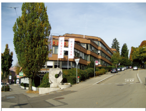
No. 99 (第8回) 作品名：Geschäftshaus SUISA 施主：SUISA, Gesellschaft der Urheber und Verleger 設計者：Werner Gantenbein 竣工年：1968
