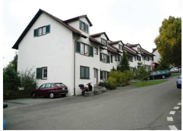
No. 2 (第1回) 作品名：Arbeitersiedlung im Riedacker <Sunnige Hof> 施主：Siedlungsgenossenschaft Sunnige Hof 設計者：Karl Kndig 竣工年：1943
