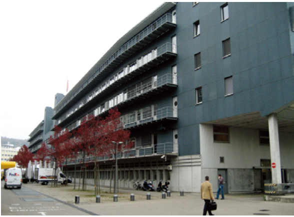
No. 149 (第13回) 作品名: Technopark Zürich 施主: Technopark Immobilien AG 設計者: I + B Architekten 竣工年: 1993
