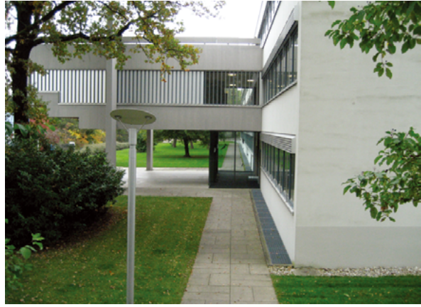
No. 66 (第6回) 作品名：Veterinärmedizinische Fakultät der Universität Zürich und Kantonales Tierspital 施主：Baudirektion des Kantons Zürich 設計者：Werner Stcheli, Jakob Frei 竣工年：1963
