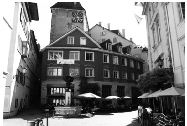
写真 3-3-6 改修事例 (No.83: 1968 年)
