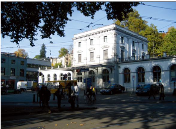
No. 139 (第12回) 作品名：Aufnahmegebäude Bahnhof Stadelhofen 施主：Schweizerische Bundesbahnen, SBB Kreis III, Zürich 設計者：Arnold Amsler 竣工年：1989
