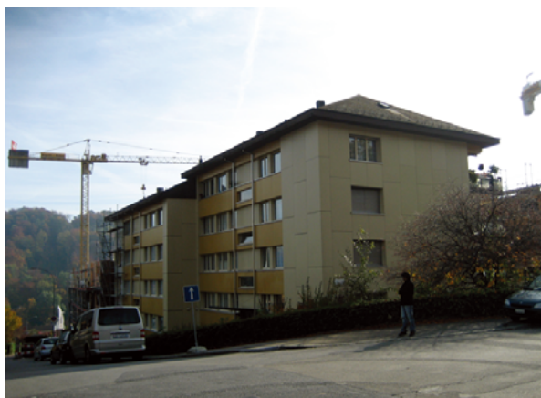
No. 47 (第5回) 作品名：Doppelhaus, 4. Etappe 施主：Baugenossenschaft Kleeweid 設計者：A. Hnni & S. Menn, H. Leuthold 竣工年：1959
