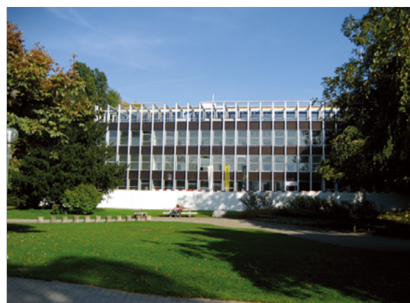
No. 40 (第4回) 作品名：Verwaltungsgebde 施主：Aluminium Industrie AG 設計者：Hans hofmann, Casetti & Rohrer 竣工年：1957
