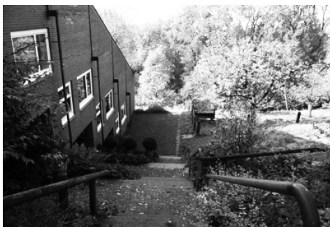
写真 4-3-2 No. 24 アプローチ
