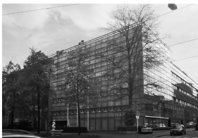
写真 5-4-7 オフィスの改修
