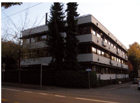
No. 87 (第7回) 作品名：Geschäftshaus Schmelzbergstrasse 施主：Verband Schweiz. Schreinermeister und Mobelfabrikanten 設計者：Werner Stcheli, Th. Huggenberger 竣工年：1967
