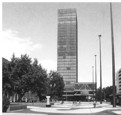
写真 5-4-8 メッセタワー
