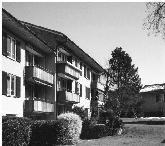
写真 4-2-1 Siedlung Hirschwiese (1953 年竣工)
