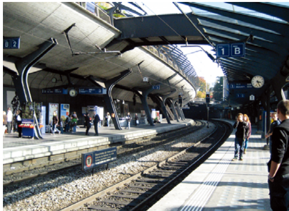
No. 140 (第12回) 作品名：Erweiterung Bahnhof Stadelhofen 施主：Schweizerische Bundesbahnen, SBB Kreis III, Zürich 設計者：Arnold Amsler, Santiago Calatrava Valls SA 竣工年：1990
