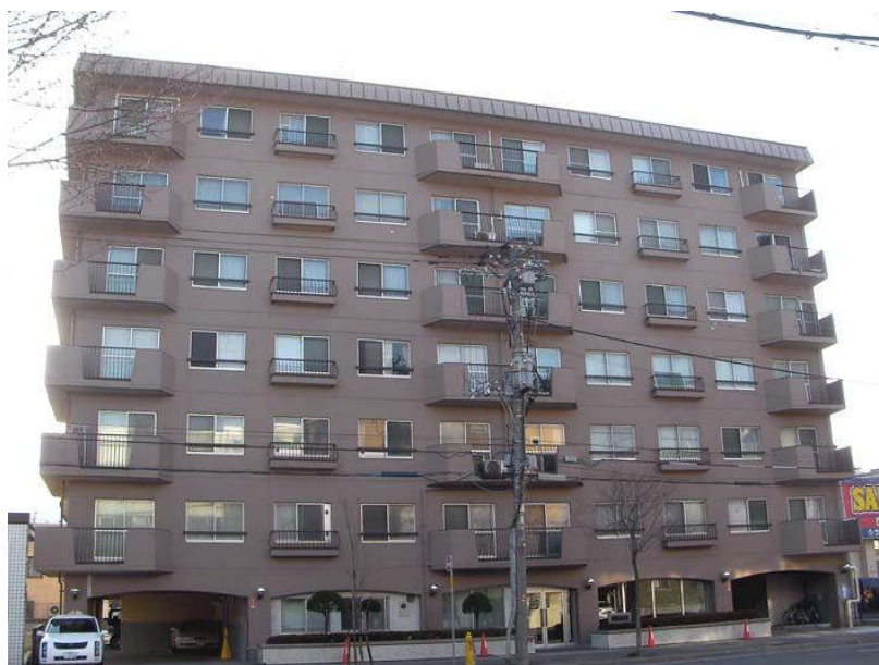
写真 4-1 M マンションの外観（改修前）
