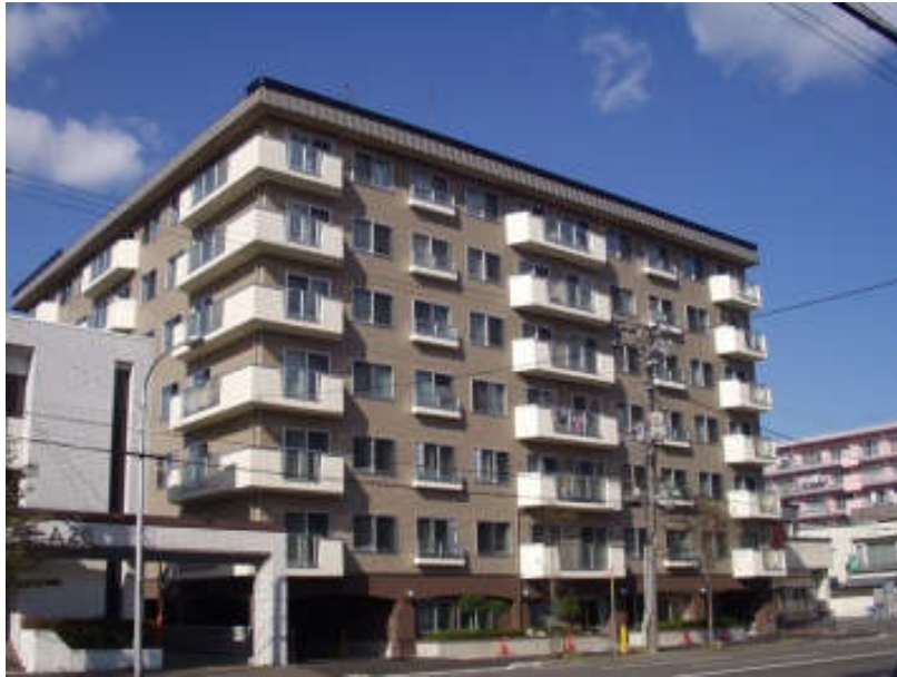
写真 4-2 M マンションの外観（改修後）
