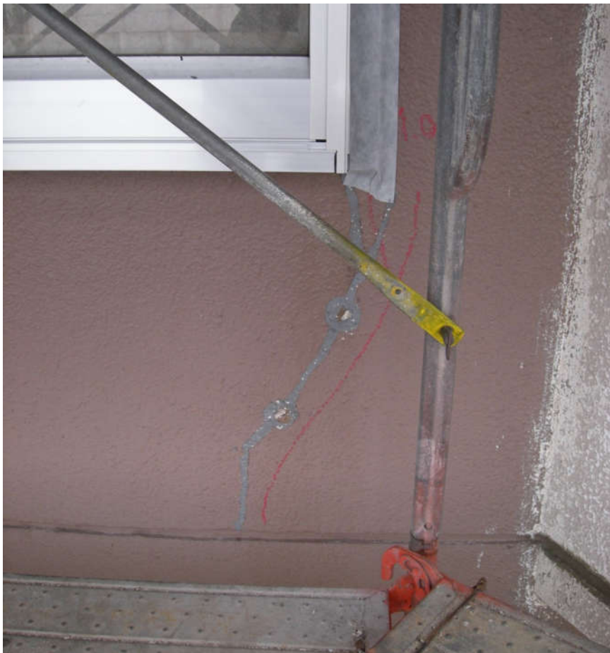
写真 4-3 コンクリート躯体ひび割れ部分の補修状況
