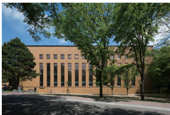
新棟（南棟）の外観
