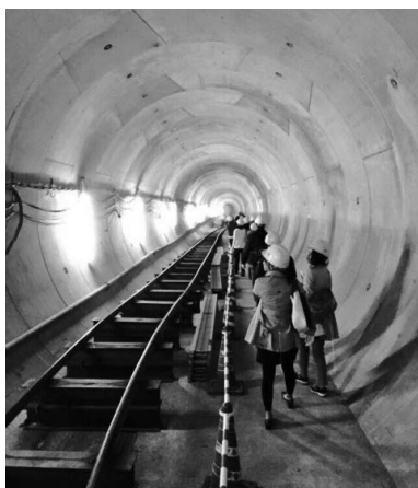
写真1 ガイドツアーの様子 (御堂筋共同溝)
