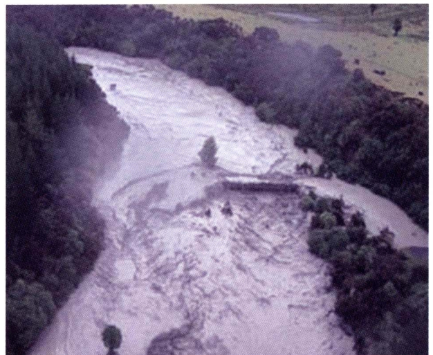
(Copyright : New Zealand Herald) 口絵写真－7 ラハールに沈むストラッチャンズ橋と道路 (通常は、ワンガエフ川は橋の下を流れている。)
