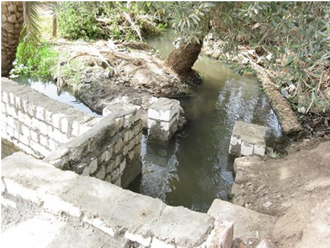
Fig. III-12 農家により補修されたメスカ（シノーリス地区）
