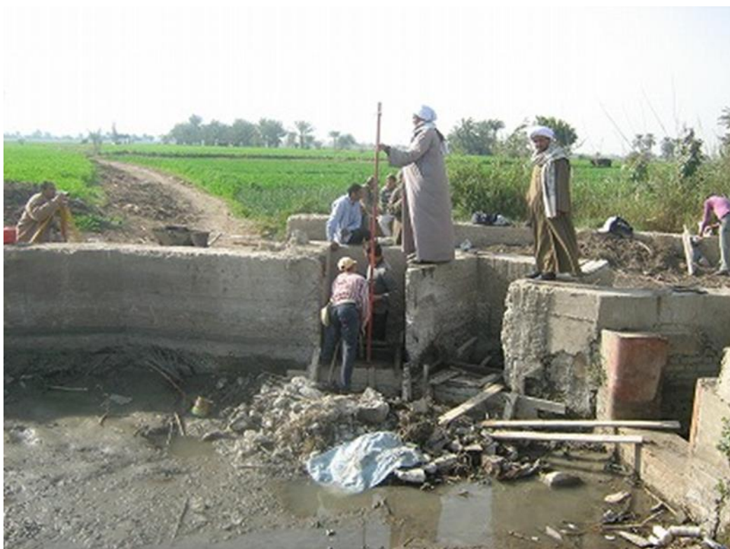
Fig. III-10 取水口改修工事の状況（シノーリス地区）
