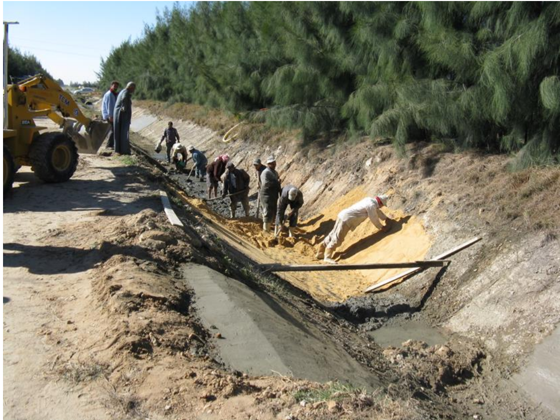
Fig. III-8 共同補修工事の実施状況（ラシュ・エル・ガルビ地区） Joint Repair Work at Rash El Gharbi pilot site
