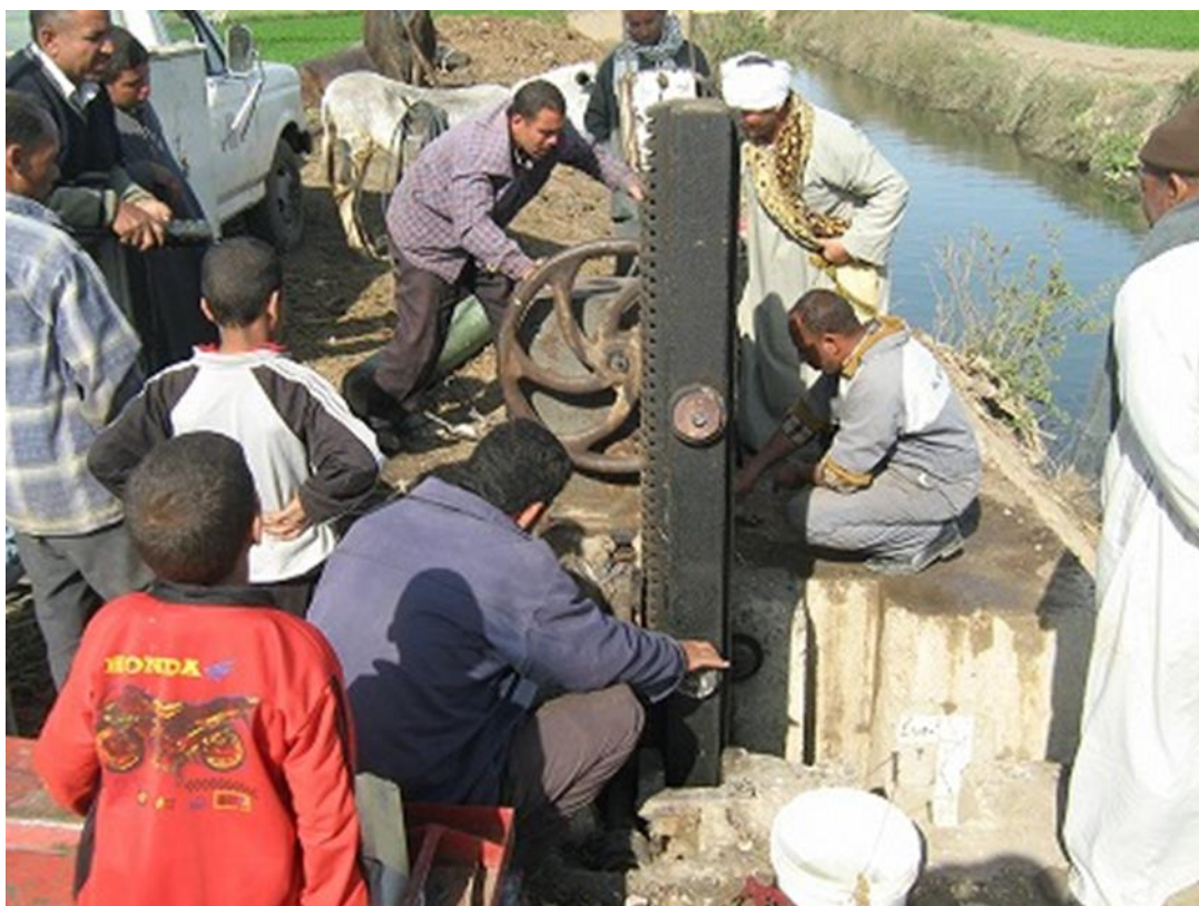
Fig. III-11 補修したゲートの動作を確認する関係者（ベニ・アビード地区） Participants confirming the operation of the repaired gate at Beni Ebeid pilot site
