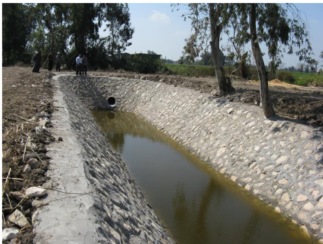
Fig. III-9 水路補修工事完成後の状況（バハル・ヌール地区）
