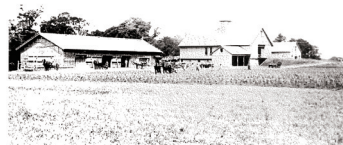
▲ ⑧地球環境科学研究科研究棟付近に存在した農校園（器械庫、模範家畜房）。器械庫で排水のための土管暗渠を製造していた（明治12～14年）。※1
