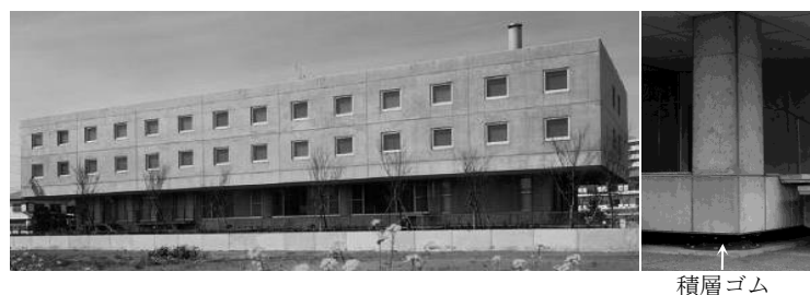
図-4.2.6 船橋竹友寮の外観と NR 系積層ゴム支承 10), 11)
