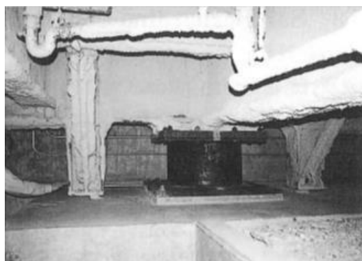
図-1.2.1 Foothill Communities Law and Justice Center のランディング機構 11)
