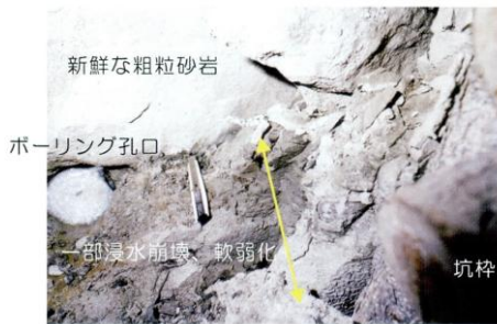
図1 ボーリング掘削水との接触部(中田ら、2004)
