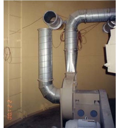
写真7 通風空気取入口の変更後の様子（変更前の写真3を参照）
