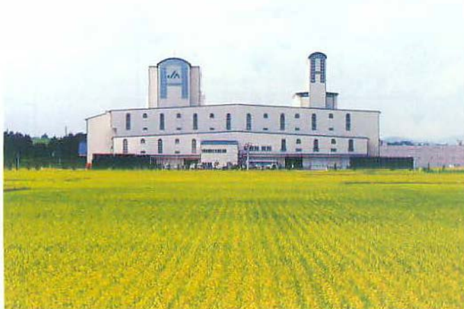
写真-1 米のカントリーエレベーター（上川ライスターミナル、計画粳処理量：11,800 t、粳貯蔵能力：10,000 t）
