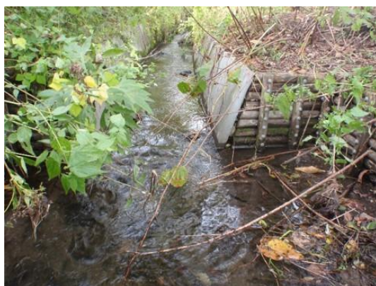
図 3.13b 3面コンクリート護岸と魚留柵
