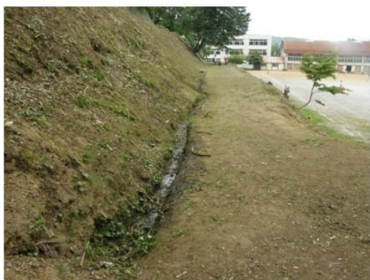
調査地C 手掘りの側溝、 この下に調査地Dがある
