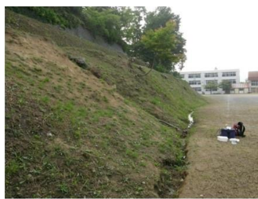
調査地D 手掘りの側溝と3面コンクリートの側 溝がある。上部に調査地Cの側溝がある
