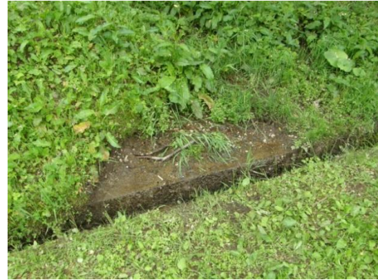
図 3.3d 側溝と側溝上部の湧水しみ出し口 (田中一典撮影)
