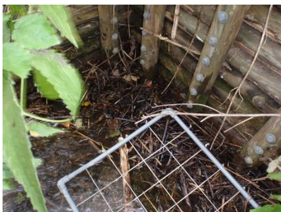
図 3.13f 魚留柵に堆積する落ち枝・落葉などのカバー物 (田中一典撮影)
