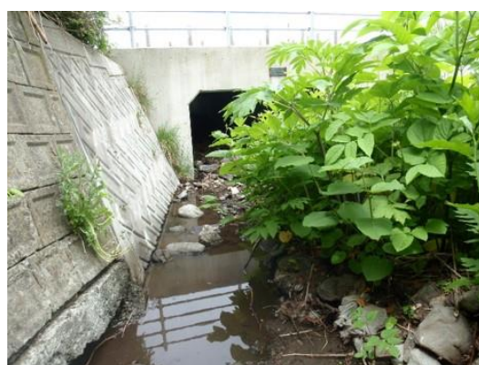
図 3.12b 一部改修されたコンクリートブロック護岸と生息場所下部 （田中一典撮影）
