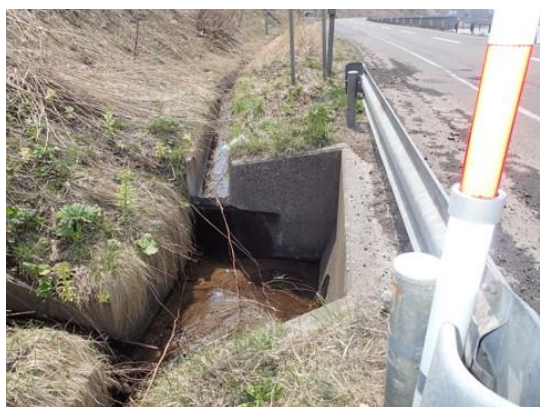
図 3.11a 国道脇にあるコンクリート集水枡 (田中一典撮影)
