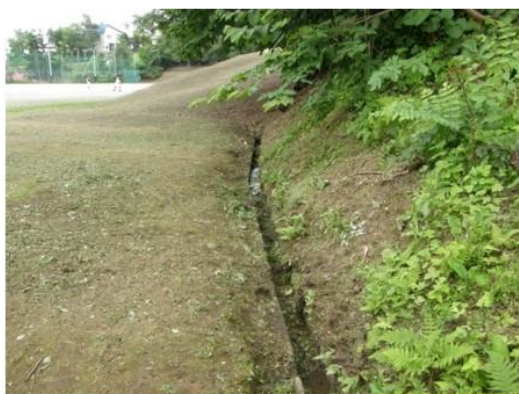
調査地点B 3面コンクリートの側溝
