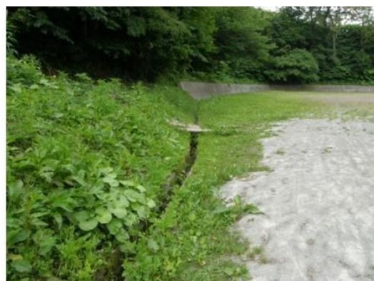
調査地点A 3面コンクリートの側溝
