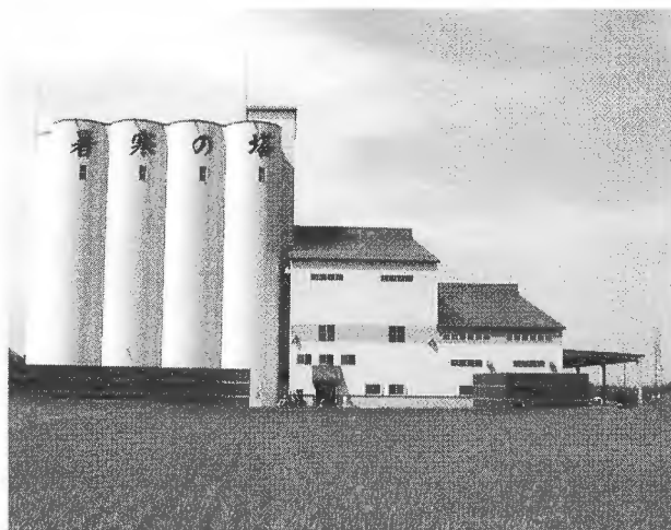
図8 米のカントリーエレベータのサイロ群 （北海道雨竜町ライスコンビナート） 粳貯蔵能力 480 \text{ t} \times 12 \text{ 基} = 5760 \text{ t}
