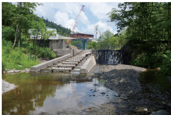
写真 1: 魚道設置後の第 1 治山ダム (2015 年 6 月)
