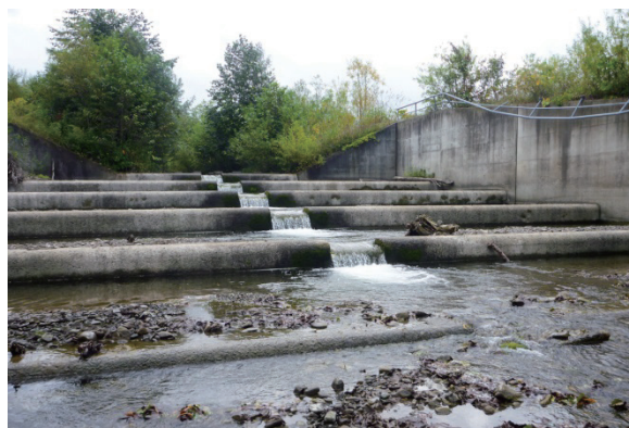
写真 8: 落差工 I (2015 年 9 月)
