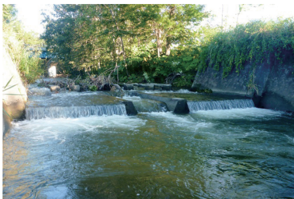
写真 9: 落差工 II (2016 年 8 月)
