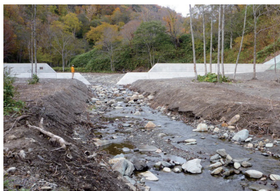
写真 6: 床固工 II (2014 年 10 月)
