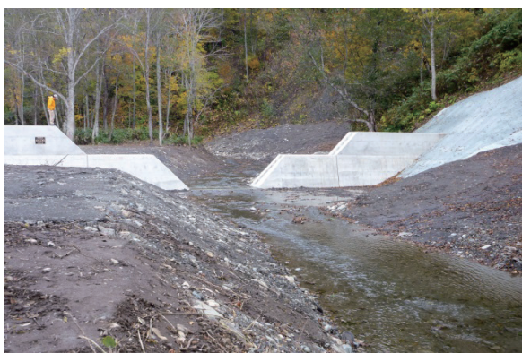
写真 5: 床固工 I (2014 年 10 月)
