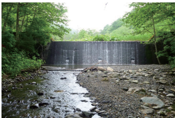
写真 3: スリット化前の第 3 治山ダム (2013 年 6 月)
