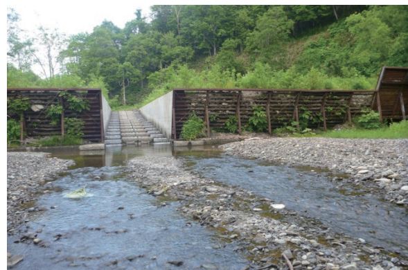
写真 2: 魚道設置後の第 2 治山ダム (2015 年 6 月)
