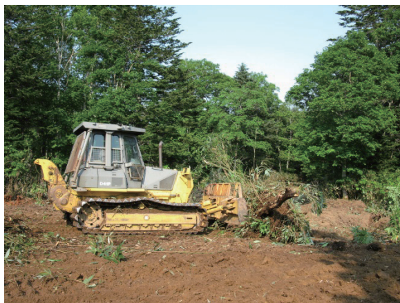
写真 1. ブルドーザーによる掻起し
