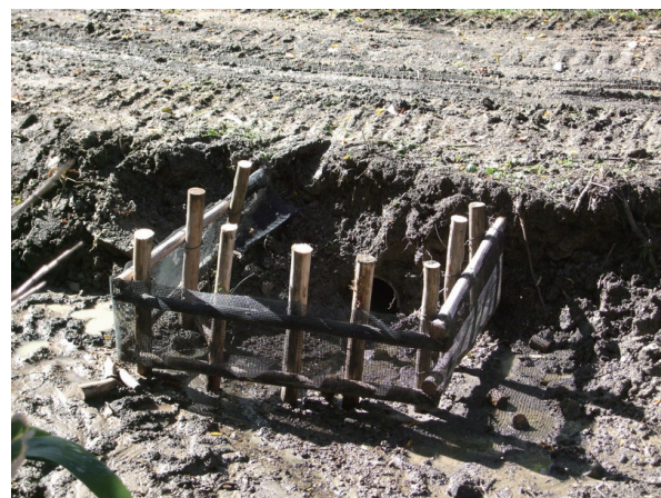
写真14. 土砂や幹枝による横断管の詰まり防止の施工
