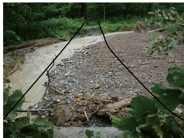
写真6. 河道移動による林道の流亡（通行不能）
