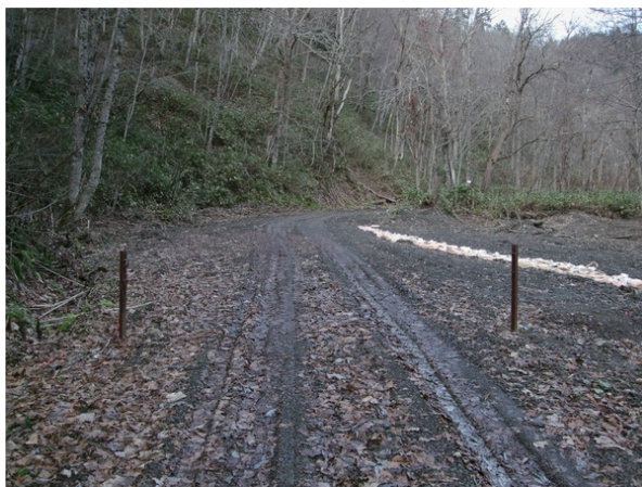
写真11. 土留めによる修復
