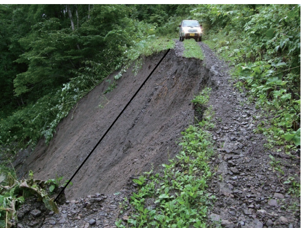
写真5. 法面浸食による林道崩壊（通行不能）
