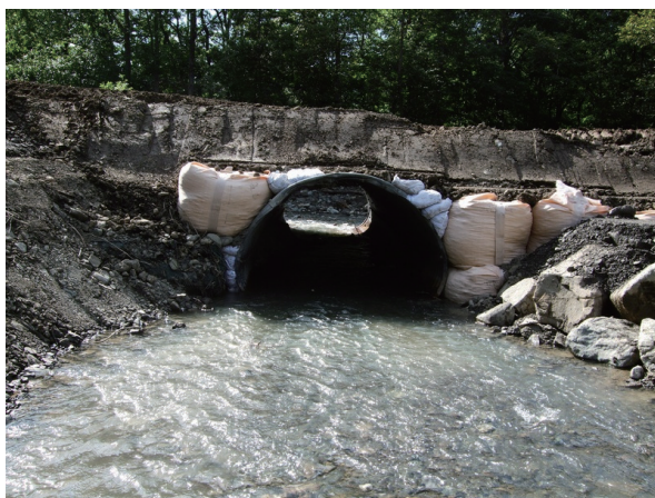
写真13. 横断管飲口の土砂流出防止の施工
