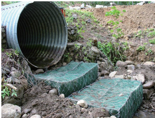
写真 2. フトンカゴ設置
