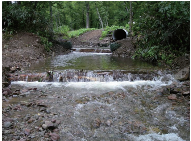
写真5. 第2ダム下流からコルゲートを望む
