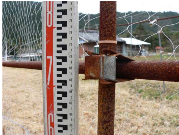
写真－ 7 支柱と横バー固定
