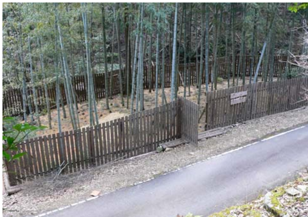
写真－2 防護柵全景
