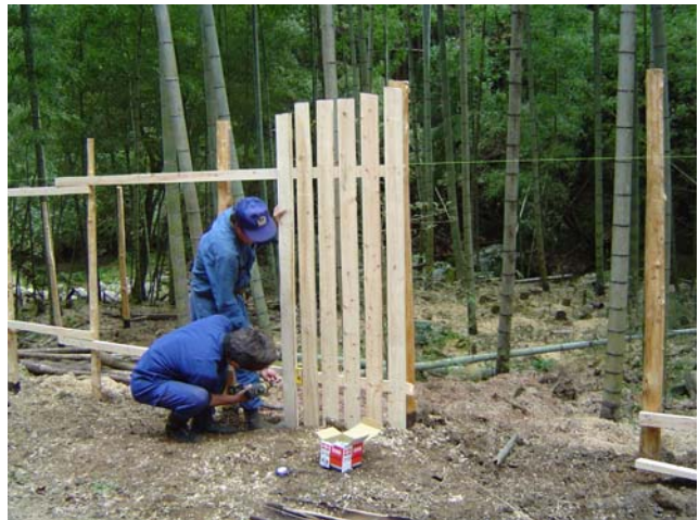
写真－1 防護柵設置作業
