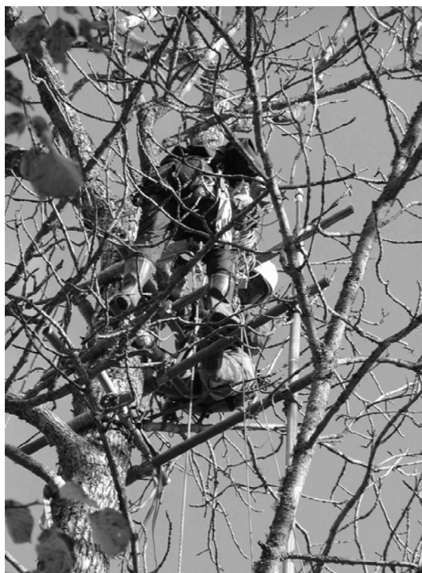
写真－８ 単管の固定作業
