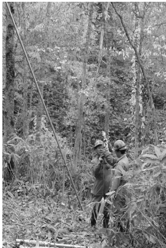
写真－９ 観測機器等の荷揚げ作業
