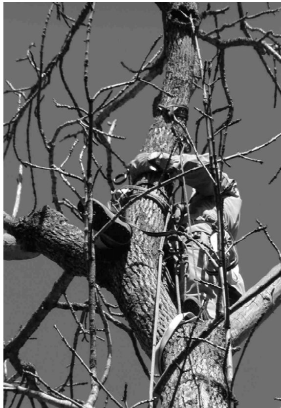
写真-5 ザイルを固定する作業状況
