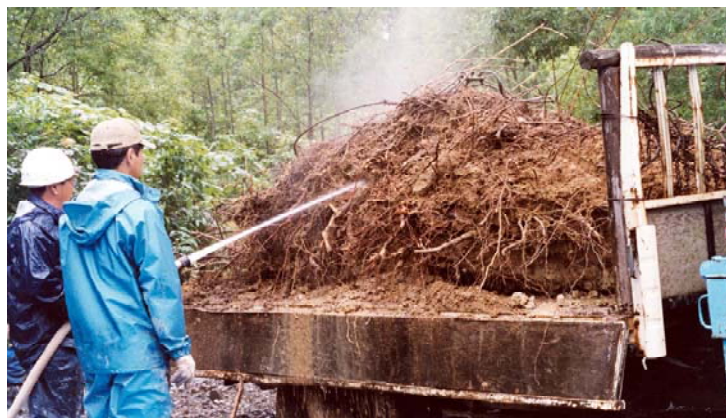
写真8 消防ポンプを用いた伐根の水洗い
