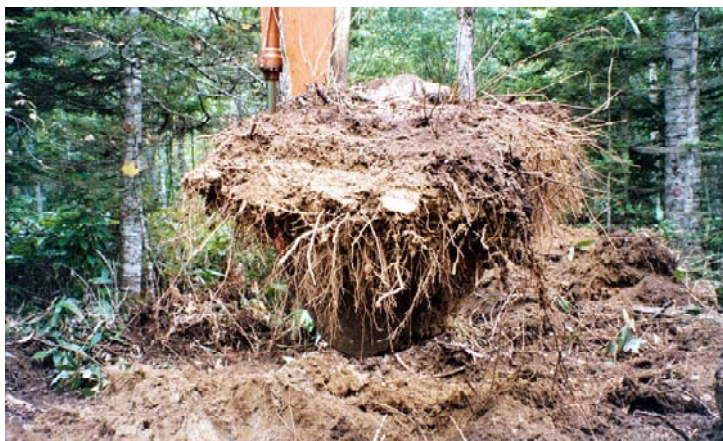
写真7 重機による伐根の掘り上げ
