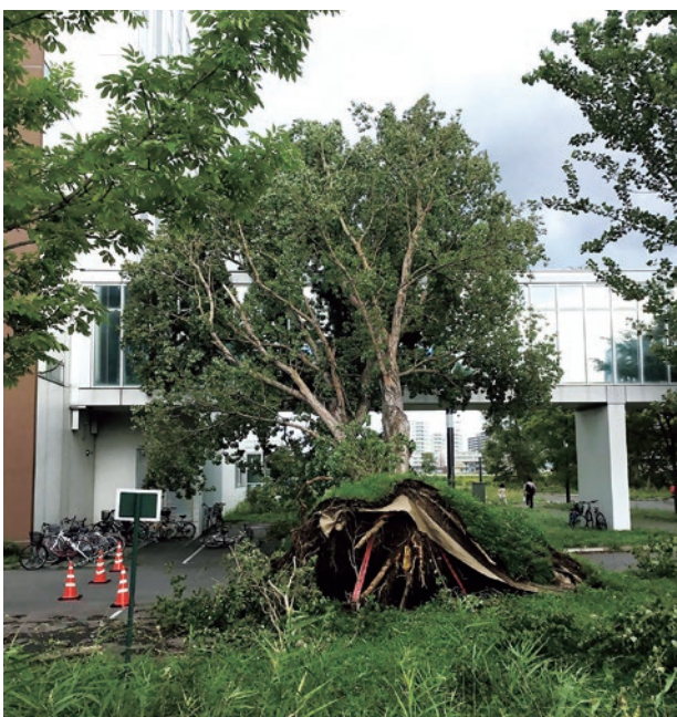
北キャンパス総合研究棟 2 号館と創成研究機構をむすぶ渡り廊下も 倒木の直撃を受けました（写真提供：ブラコマタ）
