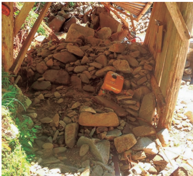
土石流に埋まってしまったモノレール。8月28日撮影 (写真提供：和歌山研究林)
