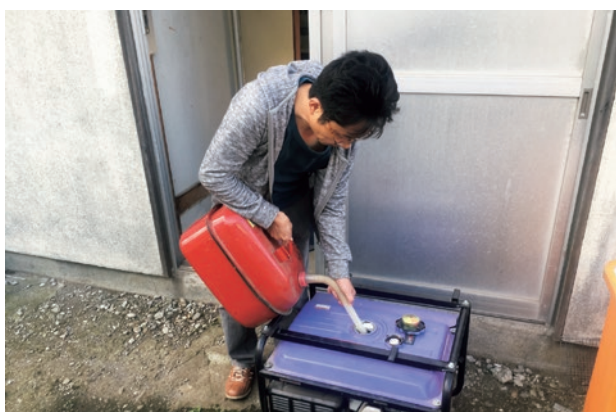
養蚕室用の発電機に燃料を補給する職員さん。 9月6日朝6時半頃撮影
