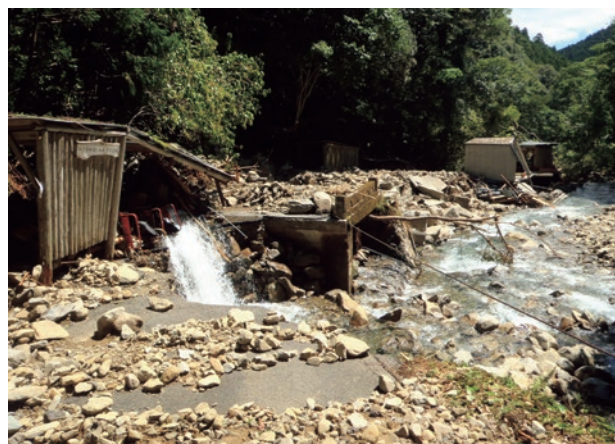
土石流で損壊・流出した倉庫。左の倉庫の中に見える赤い機械はモノレールの客車部分。8月28日撮影（写真提供：和歌山研究林）
