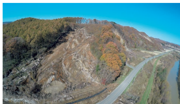
大規模な斜面崩壊発生現場を上空から撮影（撮影：谷内）
