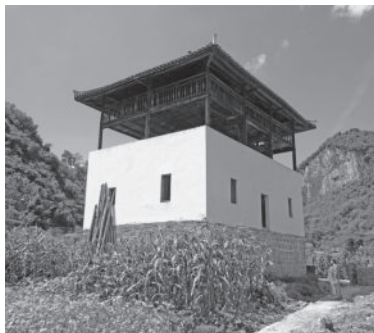
写真6 家夏土目楼房「新莊亭」(右奥が三円洞)
