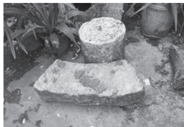
写真 17 旧北肇土目衙門碕楼アーチ型部材
