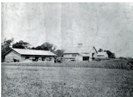
写真1 完成まもない札幌農学校模範家畜房 (No100-106、大学文書館所蔵)
