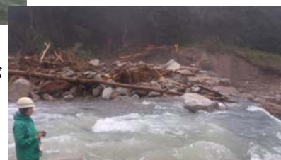
第1号砂防堰堤堆砂敷 1~2mくらいの礫径の石礫が 大量に捕捉されている。
