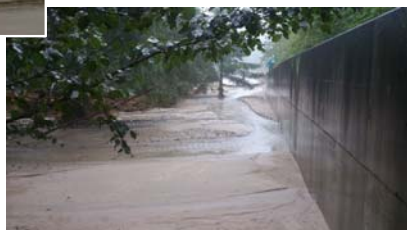
第2号砂防堰堤堆砂敷 細砂(マサ土)が 捕捉されている。 (篩い分け効果・短期的調節効果)
