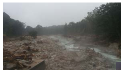
第1号砂防堰堤堆砂敷 1~2mくらいの礫径の石礫が 大量に捕捉されている。
