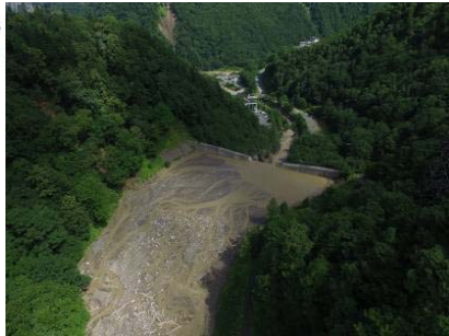
黒岳沢川第1号えん堤による土石流の捕捉(2016.8.23)
