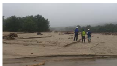
第2号砂防堰堤堆砂敷 細砂(マサ土)が 捕捉されている。 (篩い分け効果・短期的調節効果)
