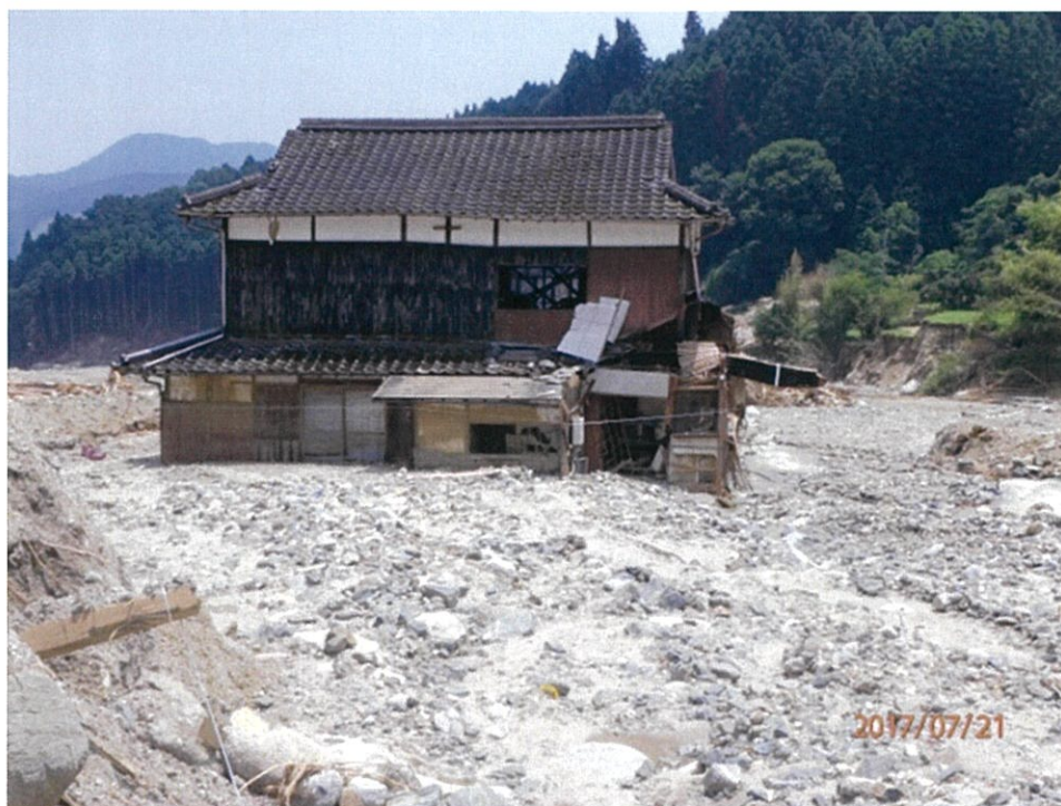
写真－3.1 乙石川・中村地区における土砂堆積状況（上流から下流を見下した写真）
