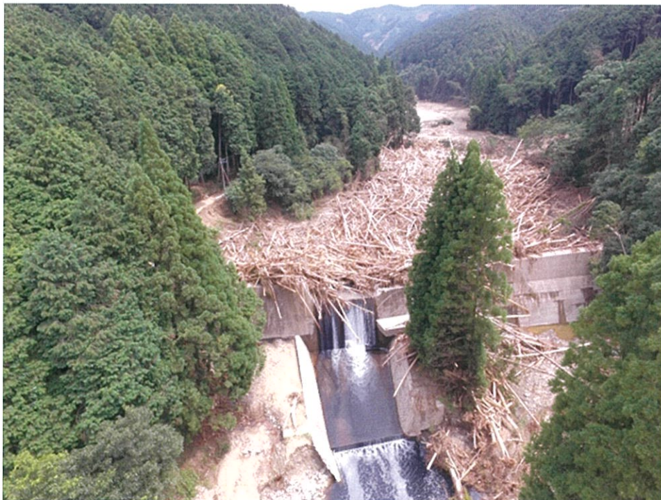
写真－3.3 妙見川・須川第一砂防堰堤における流木堆積状況
