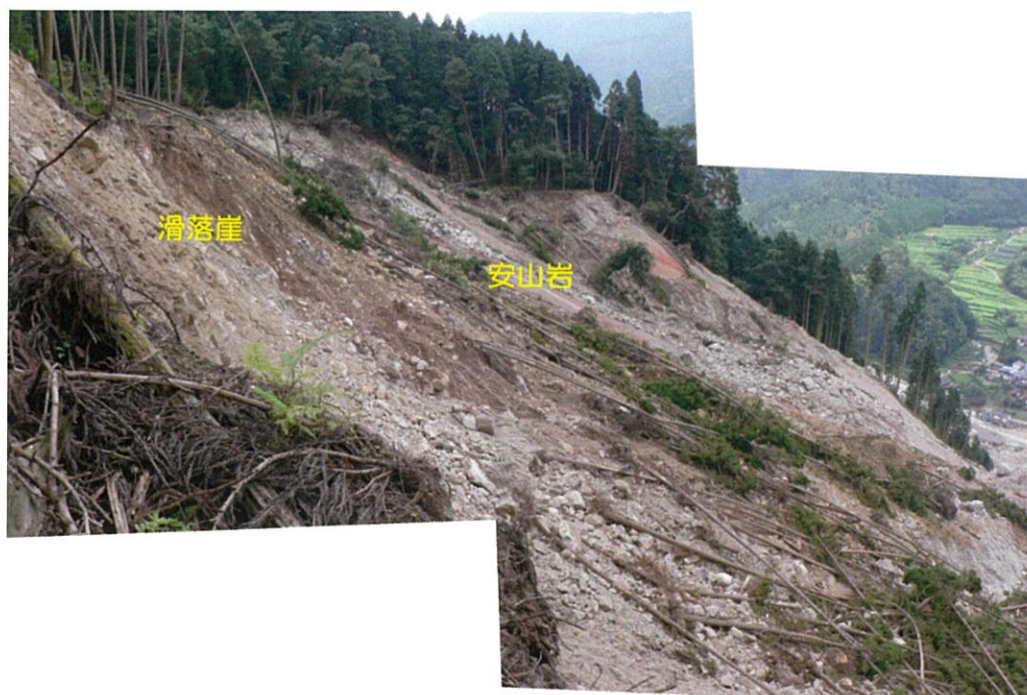
写真－4.4 小野地区の崩壊地の状況
