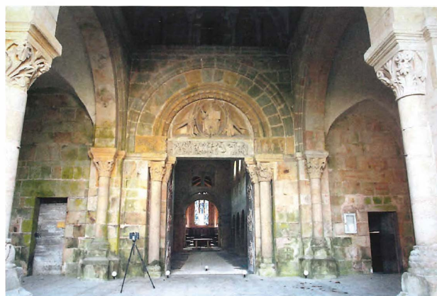
Fig. 6. Perrecy-les-Forges : vue générale du porche, infestation par les algues vertes (© Rollier).
