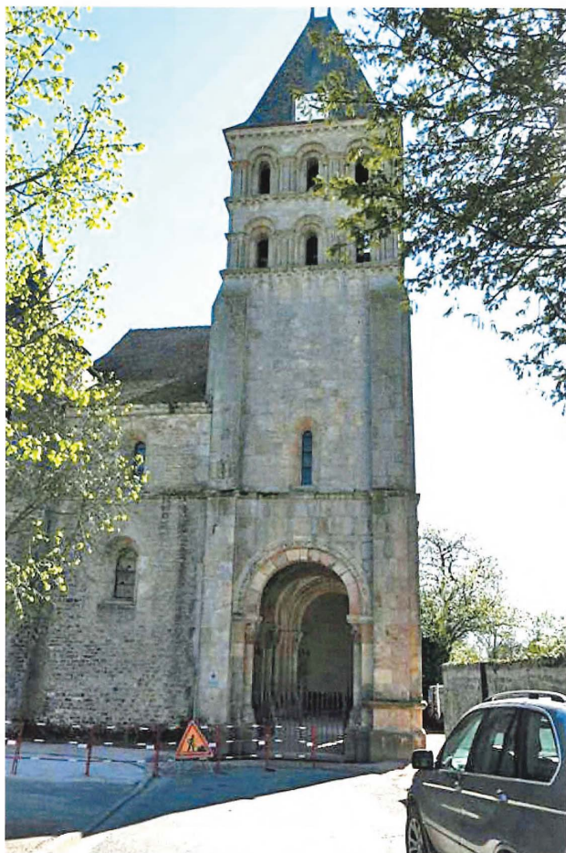
Fig. 5. Perrecy-les-Forges : vue latérale du porche (© Rollier).
