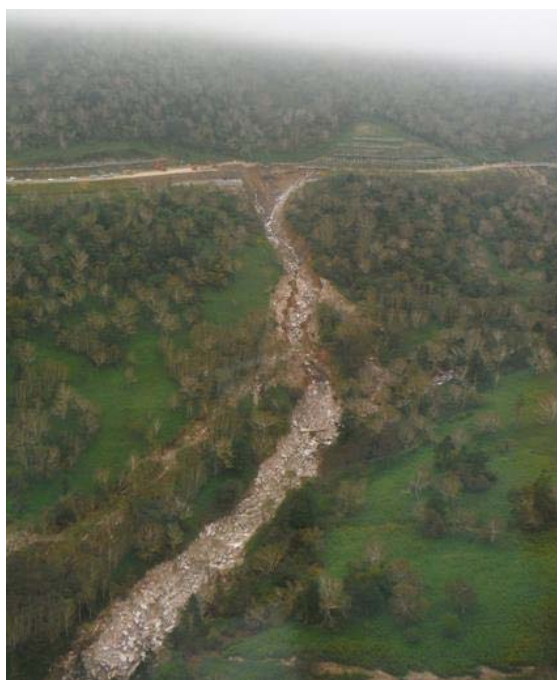
写真 2-1. R274 日勝峠崩落箇所
