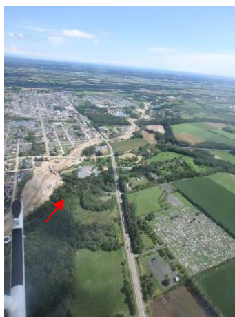
写真 h 清水町市街地における 河積の減少による氾濫、蛇行による側岸侵食
