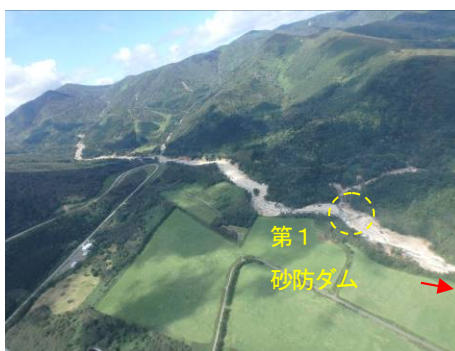
写真 f ペケレベツ川上流域の土砂流出状況、 砂防堰堤による土石流の捕捉・土砂の調節
