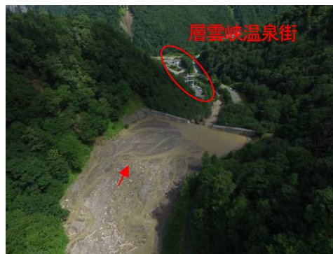
写真5 砂防堰堤による土砂の捕捉（UAVからの撮影） (提供：国土交通省北海道開発局)
