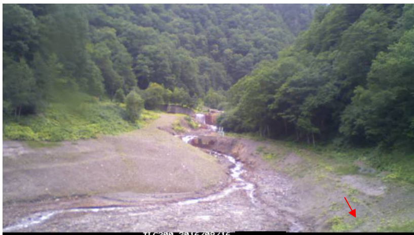
写真1 出水前（8/16 夕方撮影） （提供：国土交通省北海道開発局）
