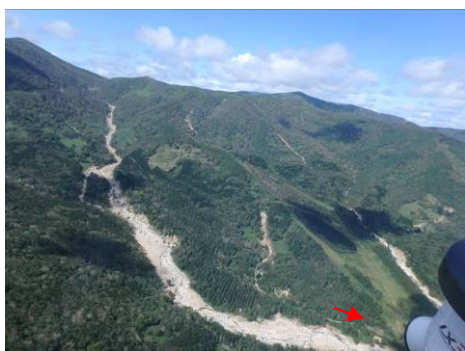
写真 e ペケレベツ川上流域の 土石流発生状況
