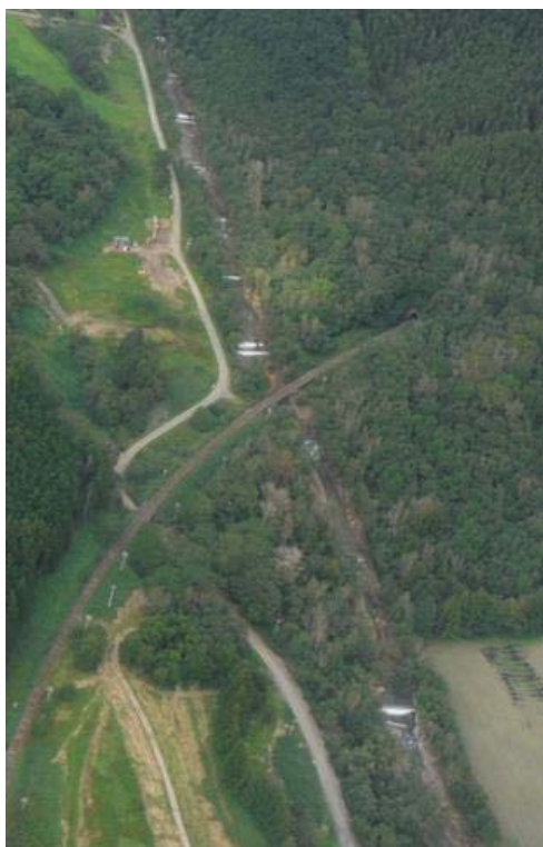
写真 3-3. 落差工と護岸による溪流保全工
