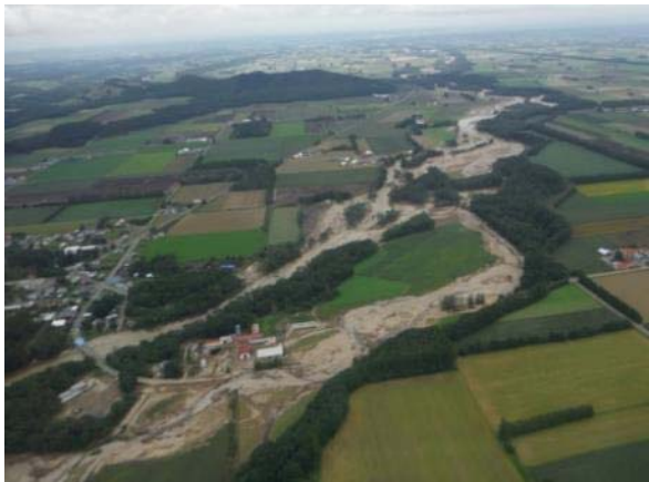
写真 1-8. 下流部での滞筋の蛇行と河岸への氾濫
