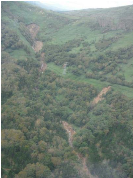
写真 3-1. 尾根部に近い斜面での崩壊
