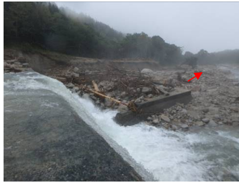
写真4 1号砂防ダム下流の礫・流木の堆積 左岸袖部の欠損, 魚道の埋塞 左岸下流部の側岸侵食とその上部の流木堆積
