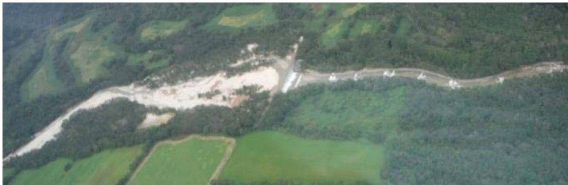
写真 2-5. 第 2 号砂防堰堤
