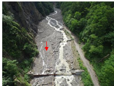
写真7 治山堰堤による土砂の捕捉（UAVからの撮影） (提供：国土交通省北海道開発局)
