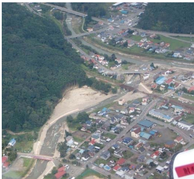
写真 3-4. 新得駅付近での氾濫
