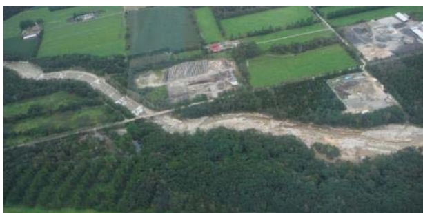
写真 2-6. 溪流保全工区間とその下流
