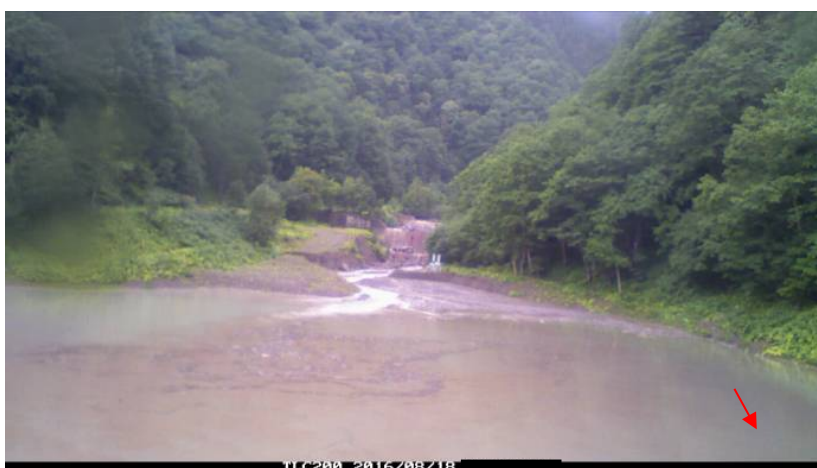
写真2 18日に発生した土砂流出（8/18 早朝撮影） （提供：国土交通省北海道開発局）
