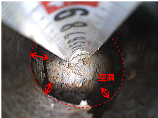
図-12 目視調査の様子
