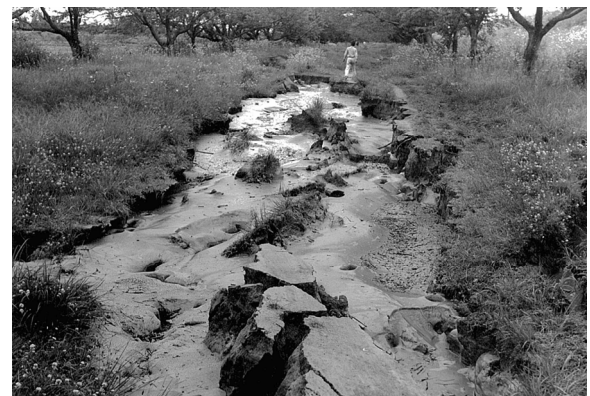
図-9 真野代堤防法尻部の噴砂状況(大河津資料館収蔵写真)
