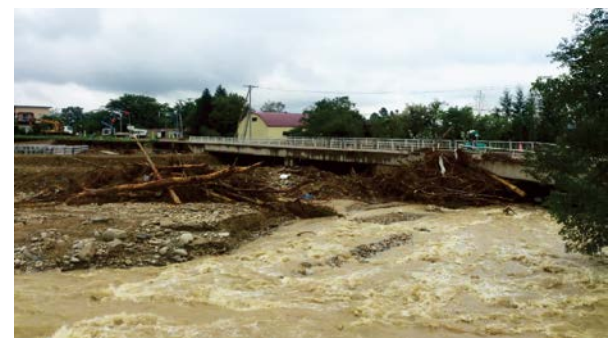
写真-2 清水町市街地ベケレベツ橋(道道)での流木・土砂による閉塞状況
