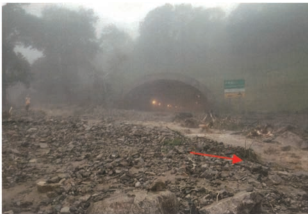
写真-1 道東自動車道狩勝第二トンネル東坑口付近における土石流 (東日本高速道路会社帯広管理事務所提供，图中赤矢印は流向を示す)
