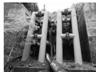
写真-21 東下田川2の地震直後(2016年4月26日撮影)の状況
