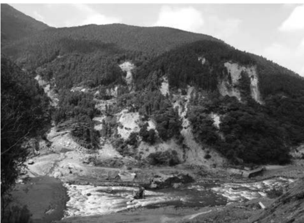
写真-15 立野地区南の白川左岸および斜面の崩壊状況 (2016年7月23日撮影)
