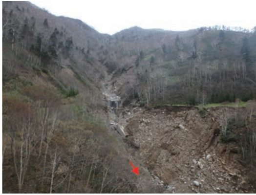
写真-3 源頭部の崩壊の状況 Photo 3 Sallow slope failure at upper stream
