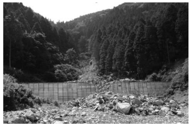
写真-3 最上流の治山ダム堆砂状況（2016年7月23日撮影）
