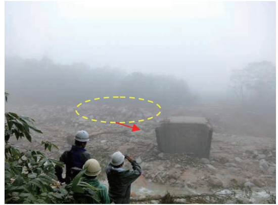
写真-4 旧日勝スキー場に向かう橋 (黄色点線囲みが巨礫の堆積) Photo 4 The bridge to closed Nisho snow park
