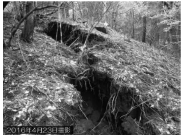
写真-1 地震で生じた亀裂
