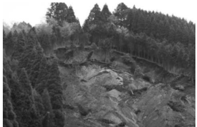
写真-10 火の鳥温泉ログ山荘に被害を出した崩壊 白っぽい強変質した火山砕屑物が目立つ（2016 年 4 月 23 日撮影）
