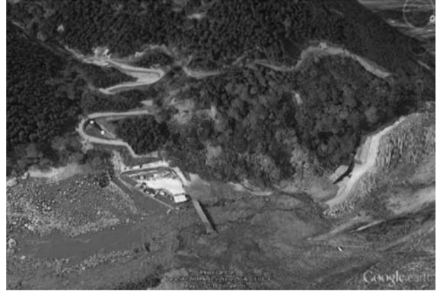
写真-16 立野地区南の白川左岸および山腹斜面の状況 (2016年4月16日 Google earth 画像)
