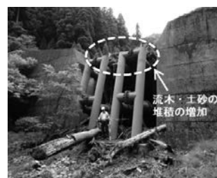
写真-22 東下田川2の砂防堰堤の土砂捕捉状況 (2016年7月24日撮影)
