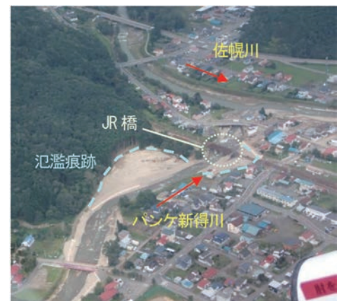
写真-2 パンケ新得川中・下流域の状況（左：九号川とパンケ新得川本川の合流地点付近の土砂堆積状況，右：パンケ新得川と佐幌川合流点付近の氾濫状況）
