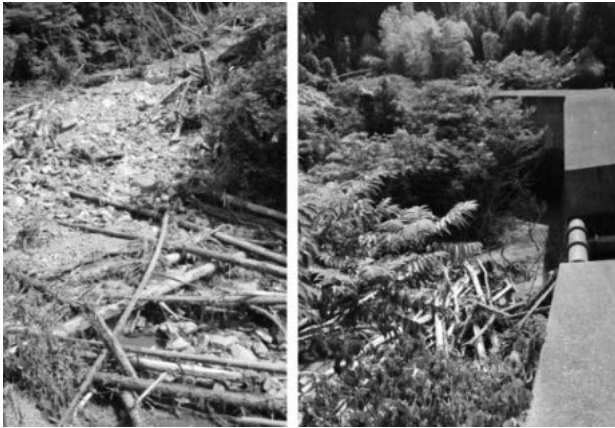
写真-18 新所川2の砂防堰堤堆砂域と堰堤による土砂補足状況 (2016年7月23日撮影)
