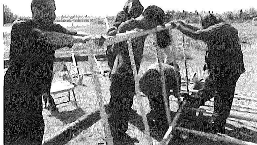
写真1 カゴの組み立て作業 (6月19日)
