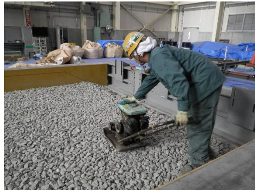
(b) 道床構築状況 (バラストの転圧)
