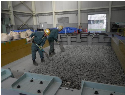
(a) 道床構築状況 (バラストの投入)
