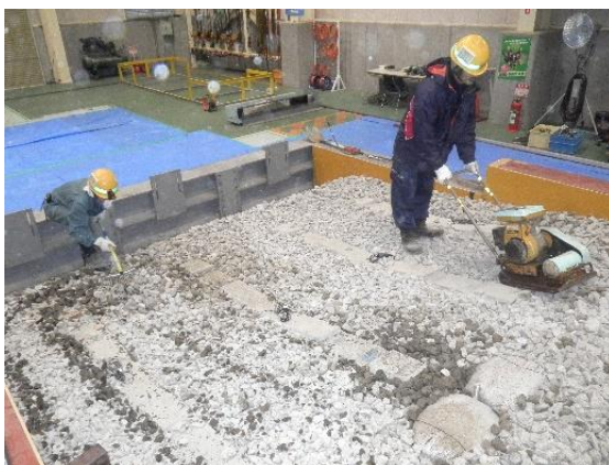
(e) 軌道整備
