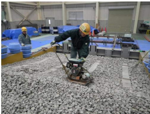
(e) まくらぎ間のバラストの転圧
