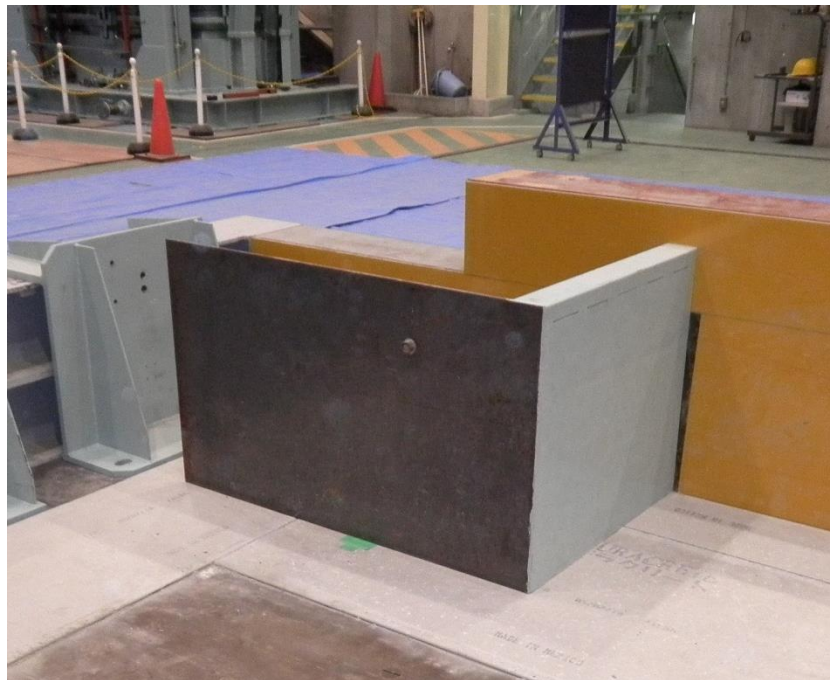
図 4.6 バラスト止め壁の設置状況
