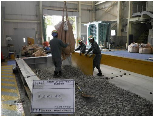
(a) 道床構築状況 (バラストの投入)
