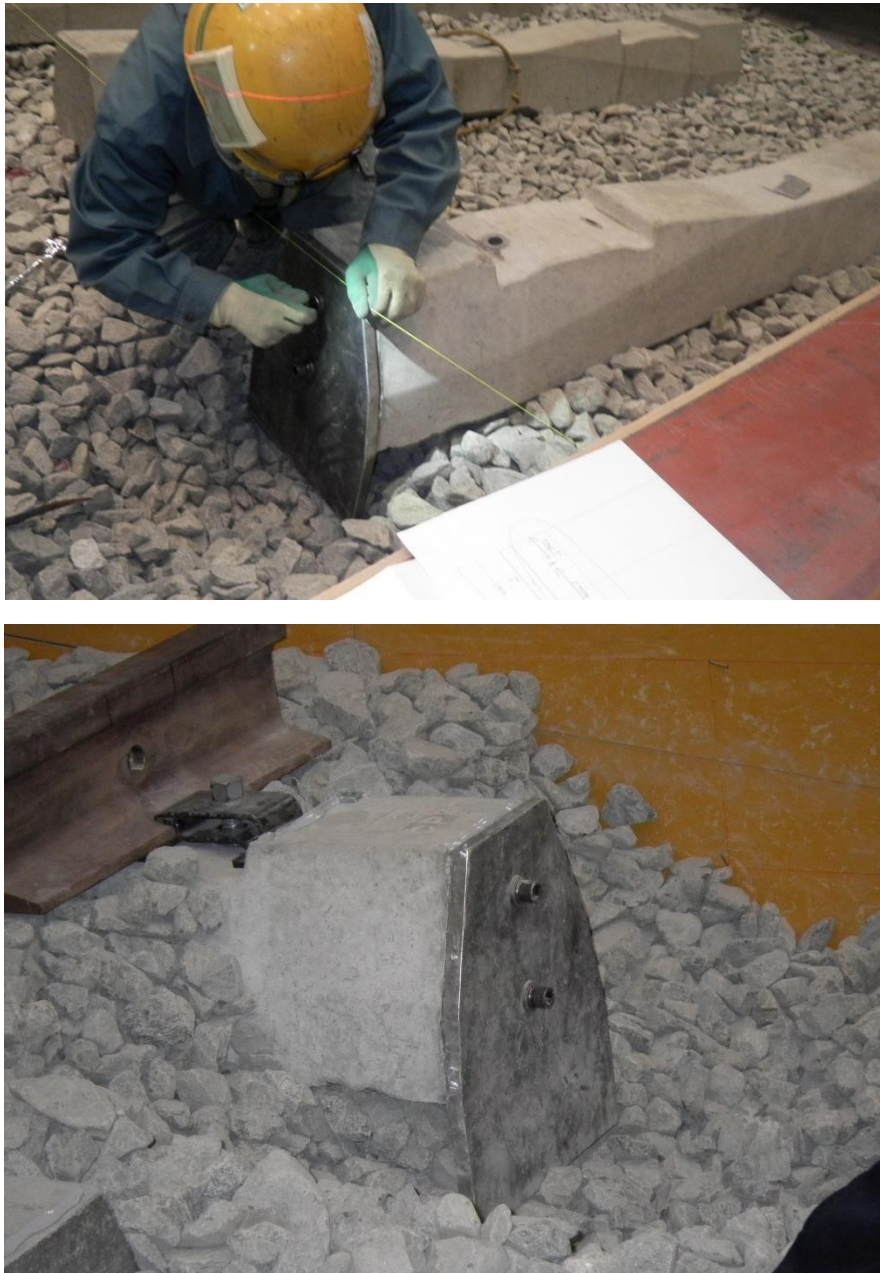
図 4.5 座屈防止板の設置状況
