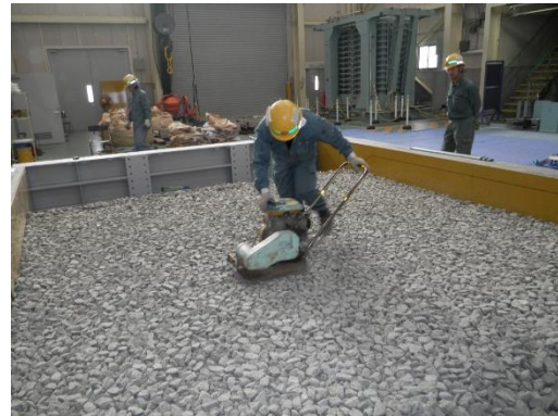
(b) 道床構築状況 (バラストの転圧)
