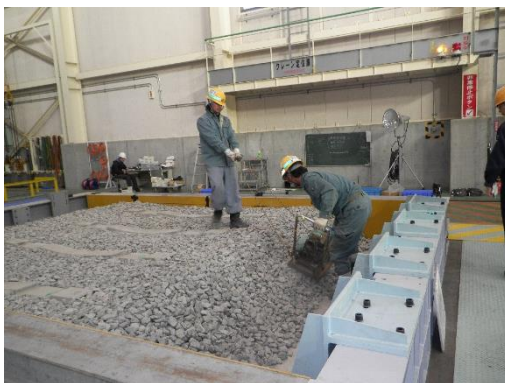
(e) まくらぎ間のバラストの転圧
