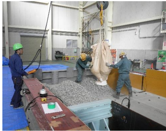
(b) バラスト敷き均し
