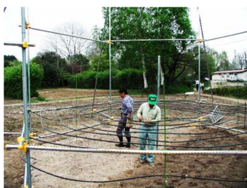
図1. 建設中のFACE（地面の白い部分は苦小牧研究林産の火山灰土壌）（上田氏提供）
