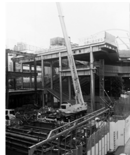
図6 工事中の宮下公園（2019年6月29日筆者撮影）
