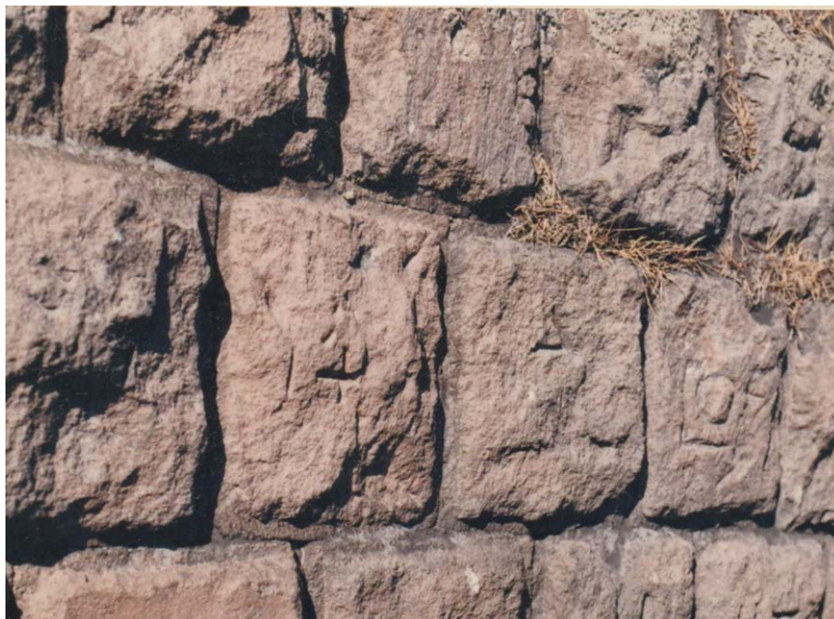
図 4.2-11 鹿児島港石積防波堤の石面に刻まれている銘
