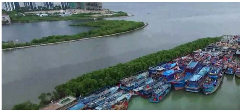
図 補.4-5 ジャカルタ漁港のマングローブ防波堤 (部分)
