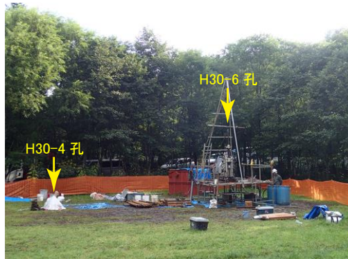
図5 SCG法原位置実証試験の掘削孔30-4孔および30-6孔
