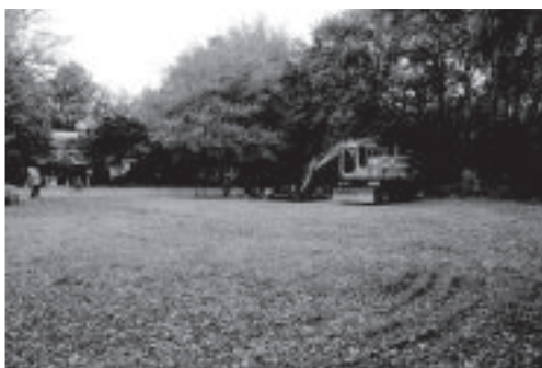
A. 調査区遠景（南東より）
