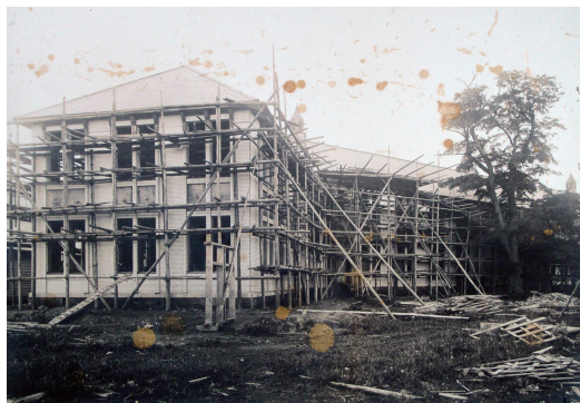
写真14 施工途中の製図室
