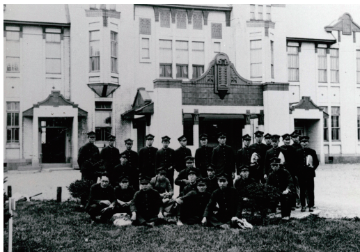
写真15 竣工間もない白堊館の正面
