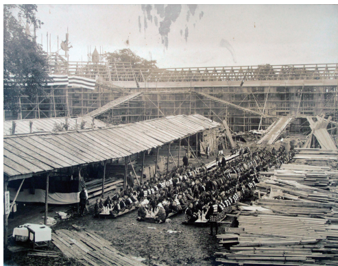
写真3 工学部本館上棟式当日祝宴場
