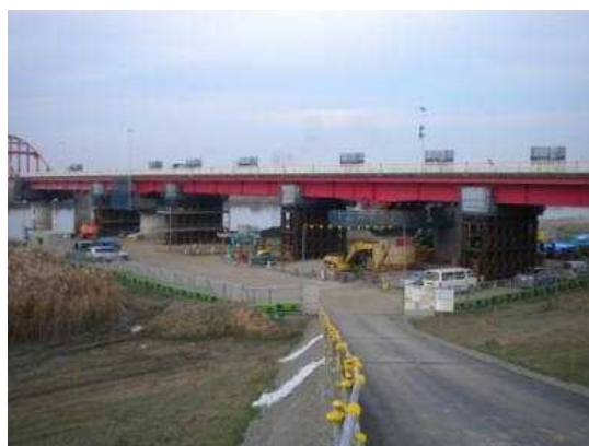
c) 仮設ベントによる仮復旧状況
