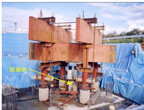
図 1.18 杭の鉛直載荷試験 34)
