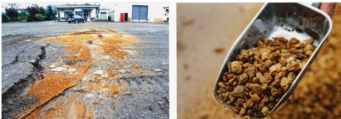
(a) 1994 年北海道東方沖地震で液状化した降下軽石（中標津町、摩周降下軽石 Ma-I） 3)
