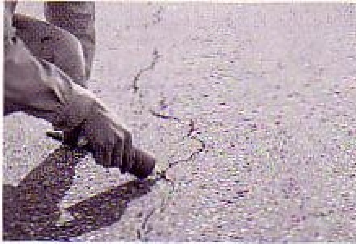
縦亀裂にサムアスファ注入の状況
