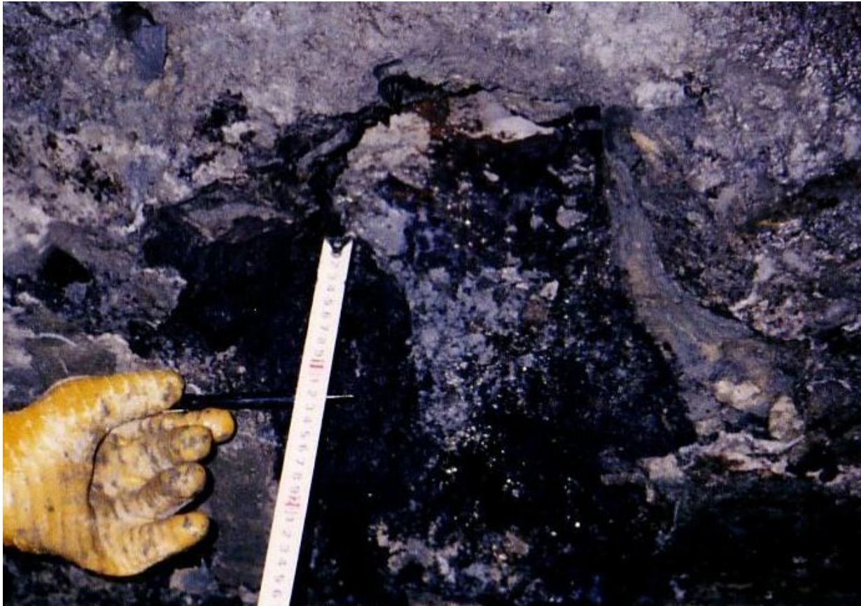
シールドトンネルの裏込め材施工1年後の状況
