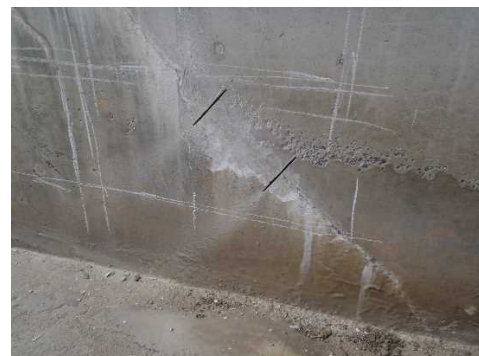
図-7.3.2 ひび割れへのクロスカット状況
