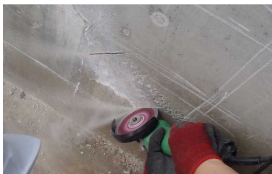
図-7.3.2 ひび割れへのクロスカット状況
