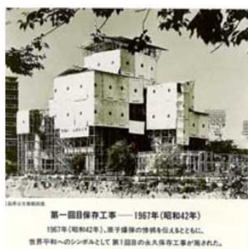
第1回原爆ドーム保存工事
