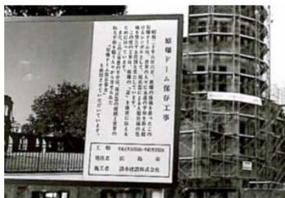
第2回原爆ドーム保存工
