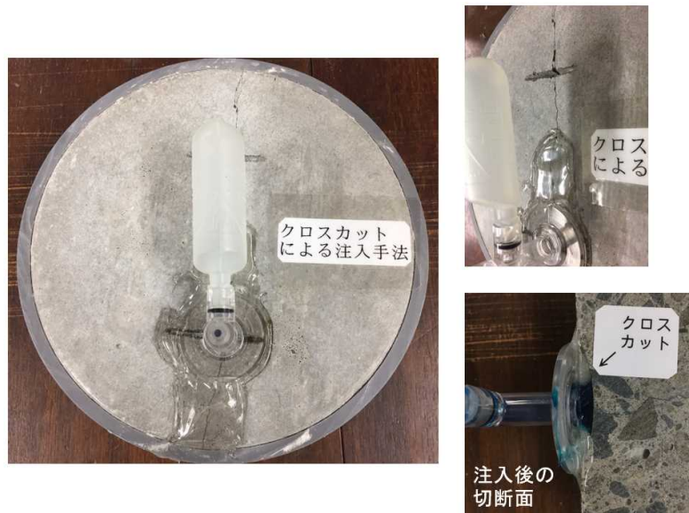
図-7.4.1 クロスカットに注入器を設置した事例と注入後のクロスカット部の切断面
