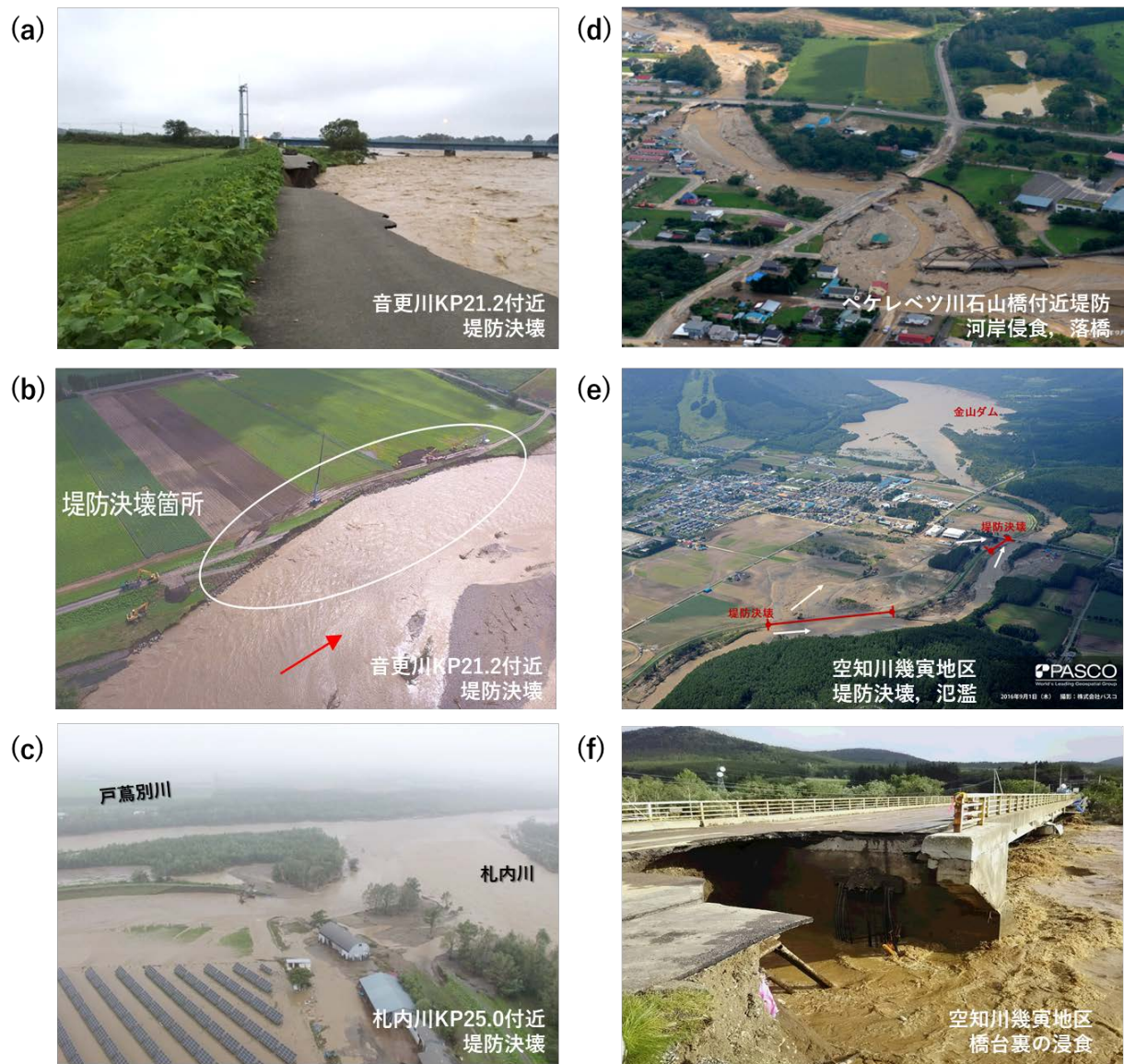
図 1-6 急流区間の被災状況
