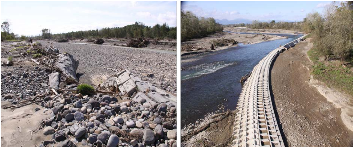
図 5-1 既設護岸の被災状況（北開水工コンサルタント撮影）
