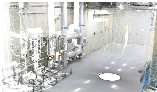
(b) 冷暖房空調設備の 3 次元計測点群
