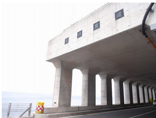
図4.6 大別苅トンネル覆道
