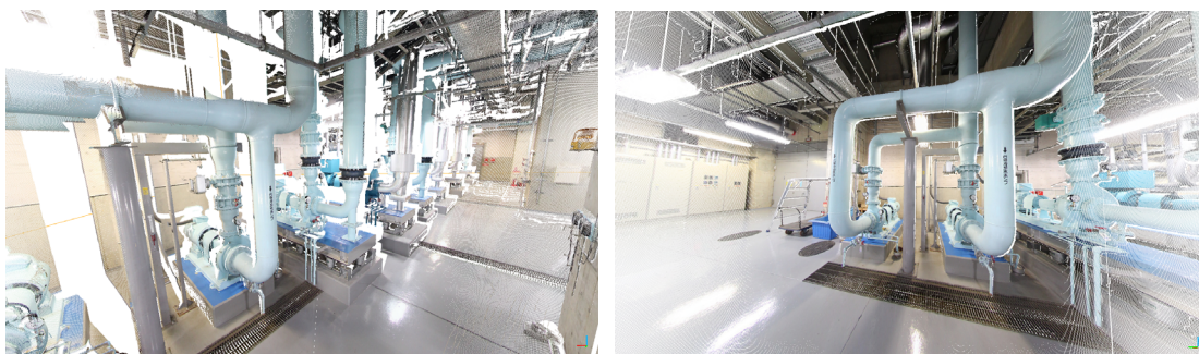
図2.61 冷暖房空調設備計測点群データ例
