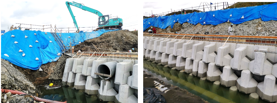
図4.10 豊浦工区護岸ブロック工事現場の初期画像例
