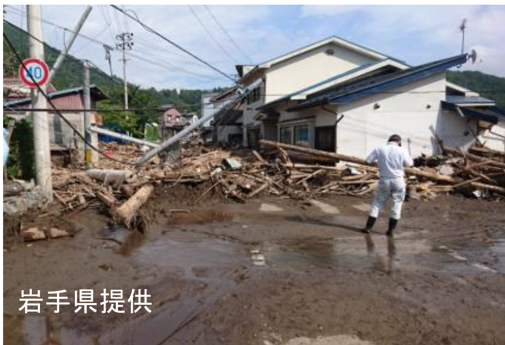
図 5.3 2016年8月東北豪雨における橋梁に隣接する家屋の被害状況
