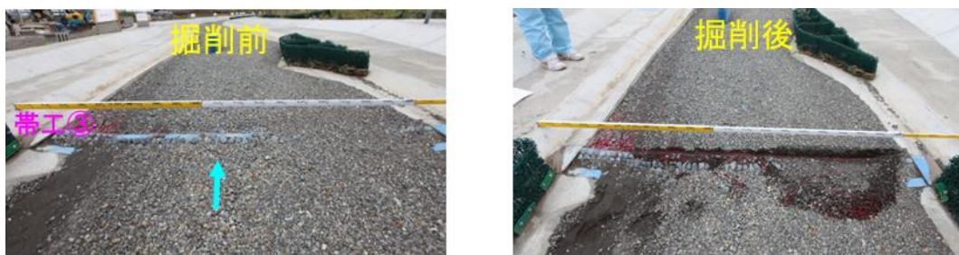
(a) 整備計画目標流量通水後の河床状況 (左：掘削前，右：掘削後)
