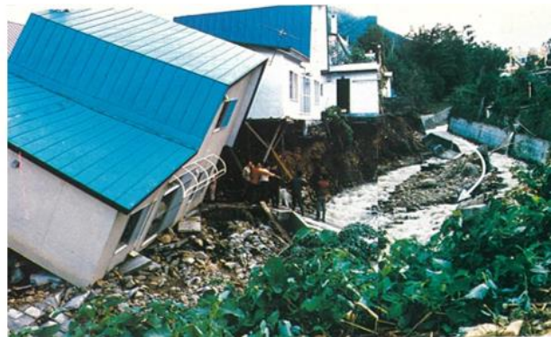
(b)豊平川支川野の沢川の河岸決壊により民家倒壊
