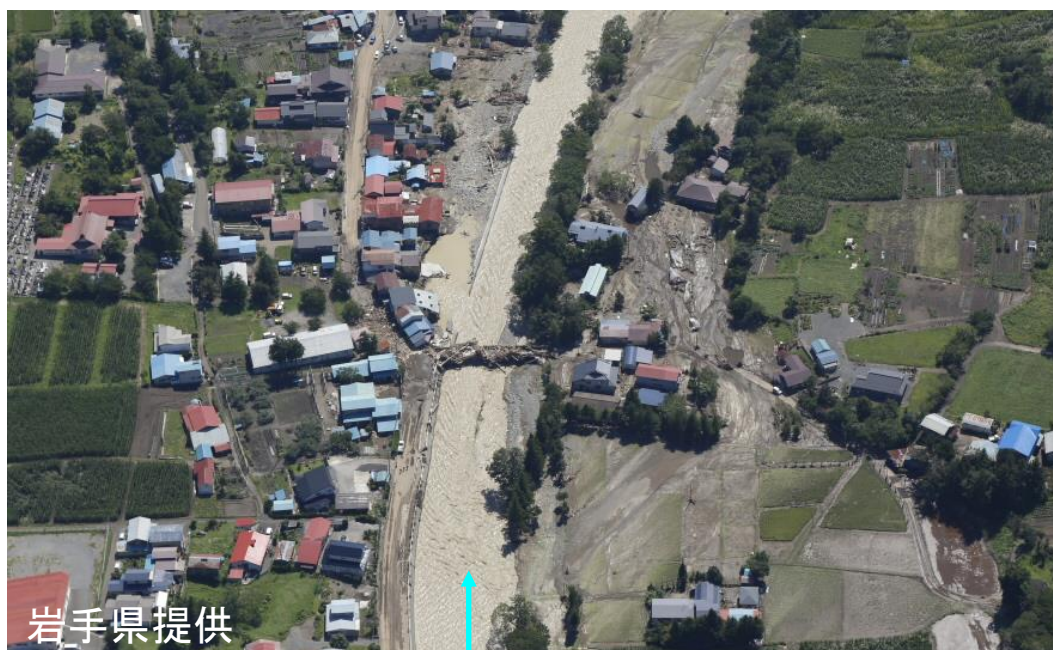
図 5.1 2016年8月東北豪雨における小本川の被災状況
