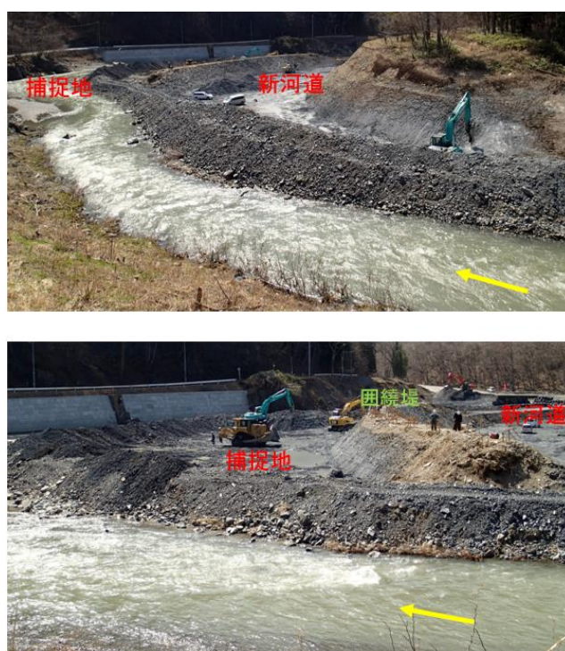
図 5.21 小本川の流木捕捉施設の施工状況（令和3年4月撮影） （写真はサンエスコンサルタント株式会社 去石氏撮影）
