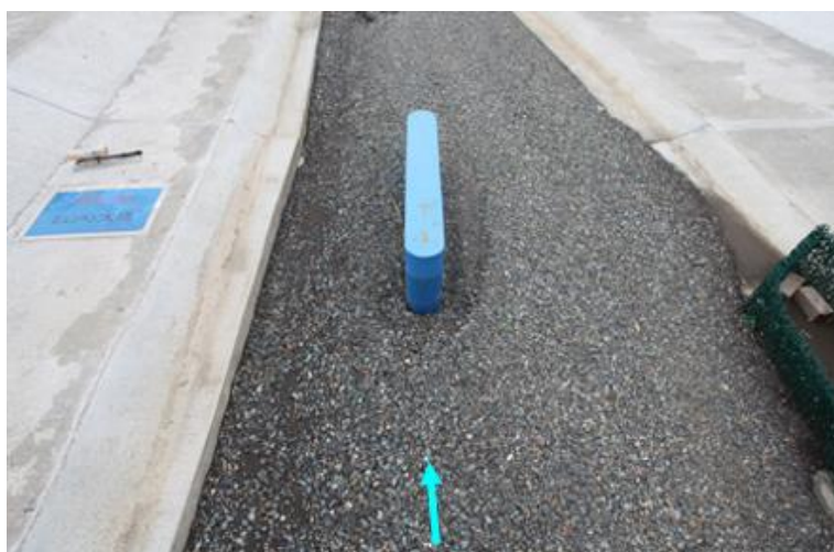
(a) 実験後の橋脚周辺の河床変動状況
