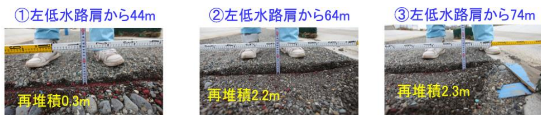
(b) 掘削後の堆積厚の計測状況
