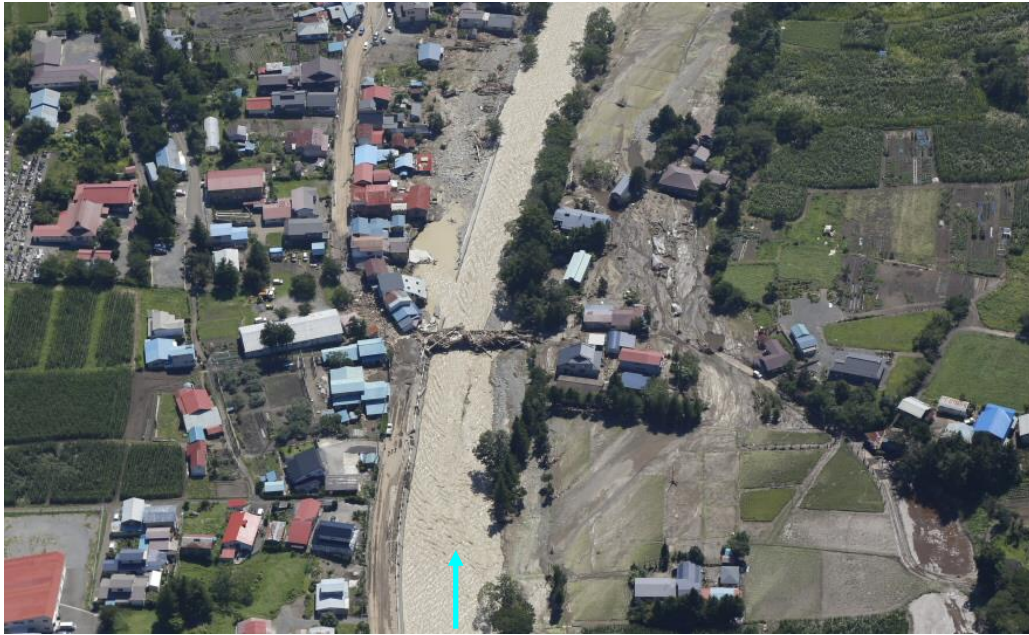
(a) 小本川沿いの洪水被害の様子
