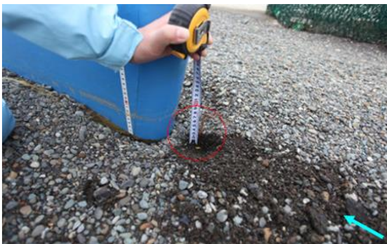
(b) 掘削後の状況
