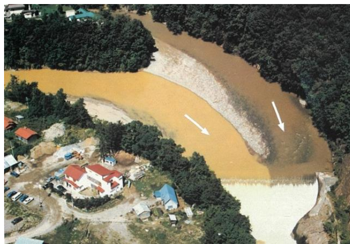
(b) 一の沢ダムの堆砂状況
