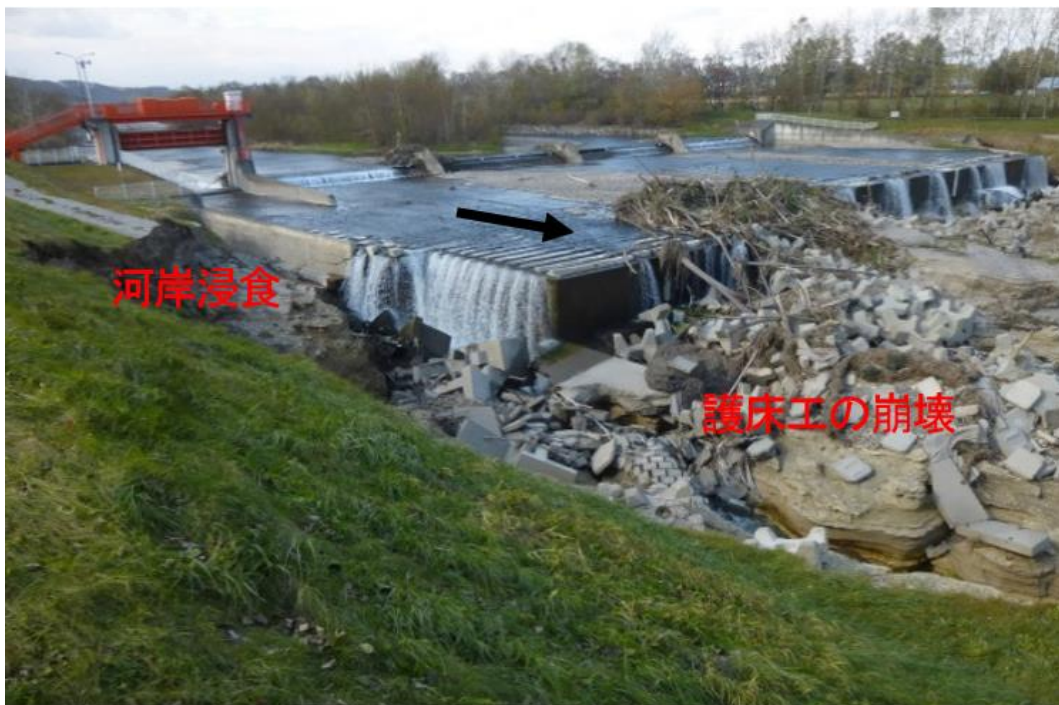
図 4.4 2016年8月北海道豪雨災害における然別川 万年頭首工下流の被災状況
